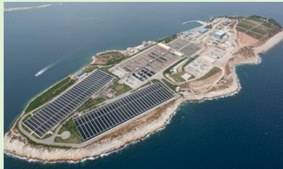
Εγκατάσταση Επεξεργασίας Λυμάτων στην Ψυττάλεια (πηγή: http://www.ypeka.gr ).
