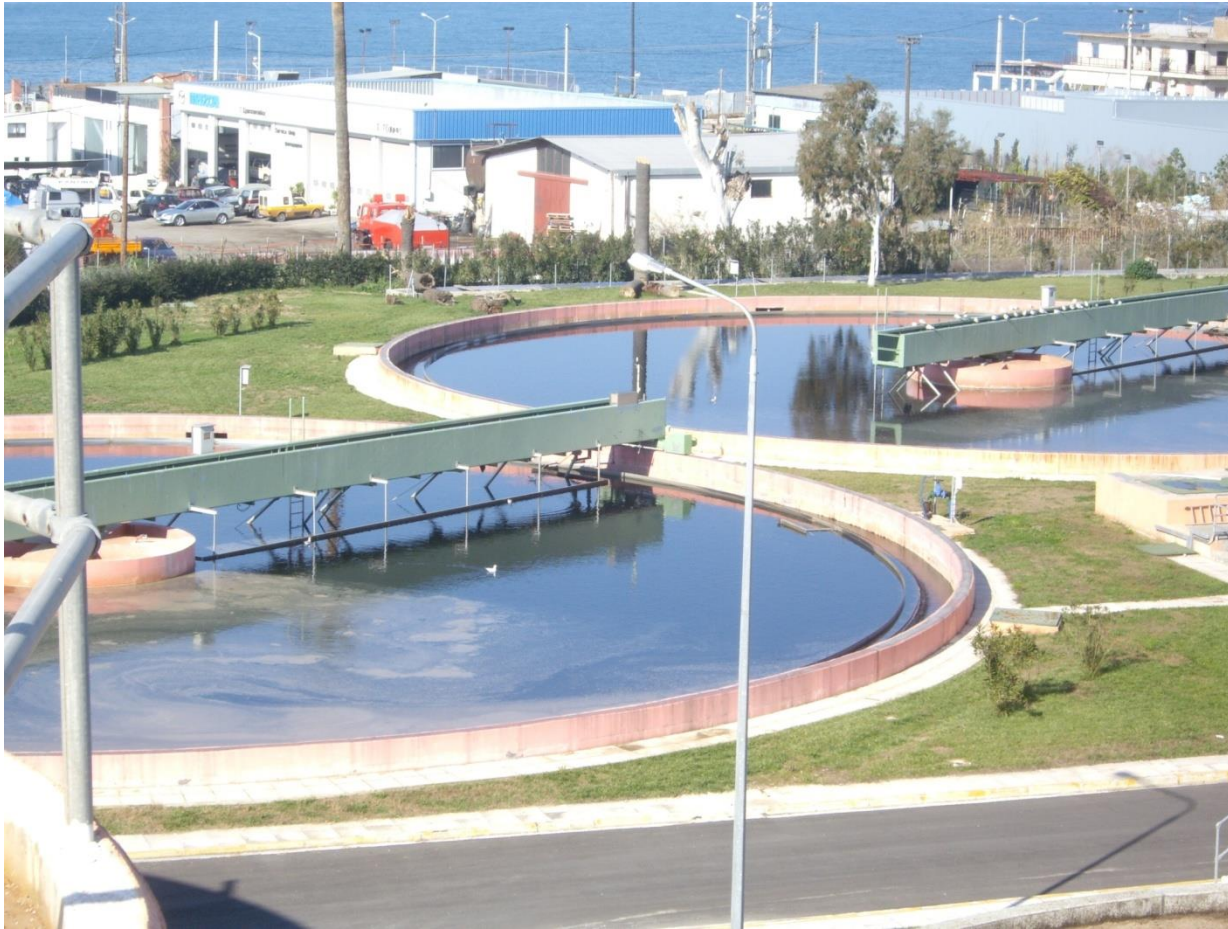
Εικόνα 2 : Βιολογικός καθαρισμός (Δεξαμενές Καθίζησης)
