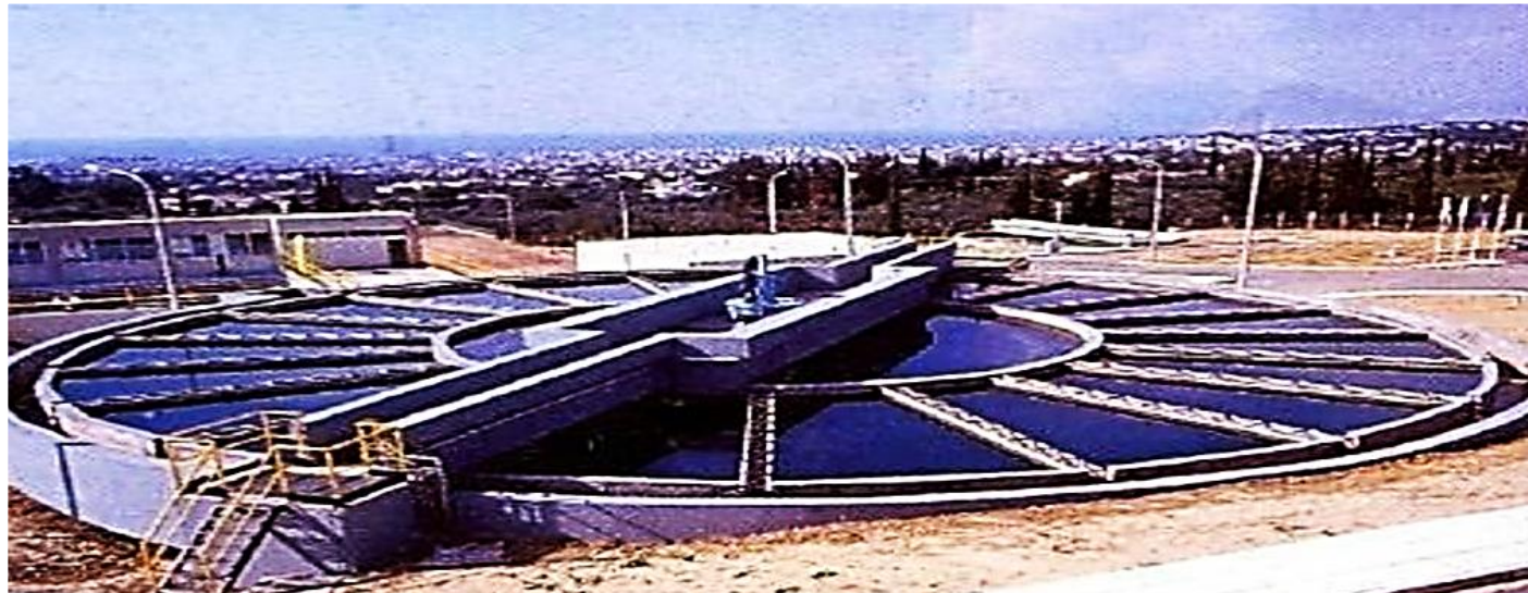
Δεξαμενή Κροκίδωσης – Καθίζησης
