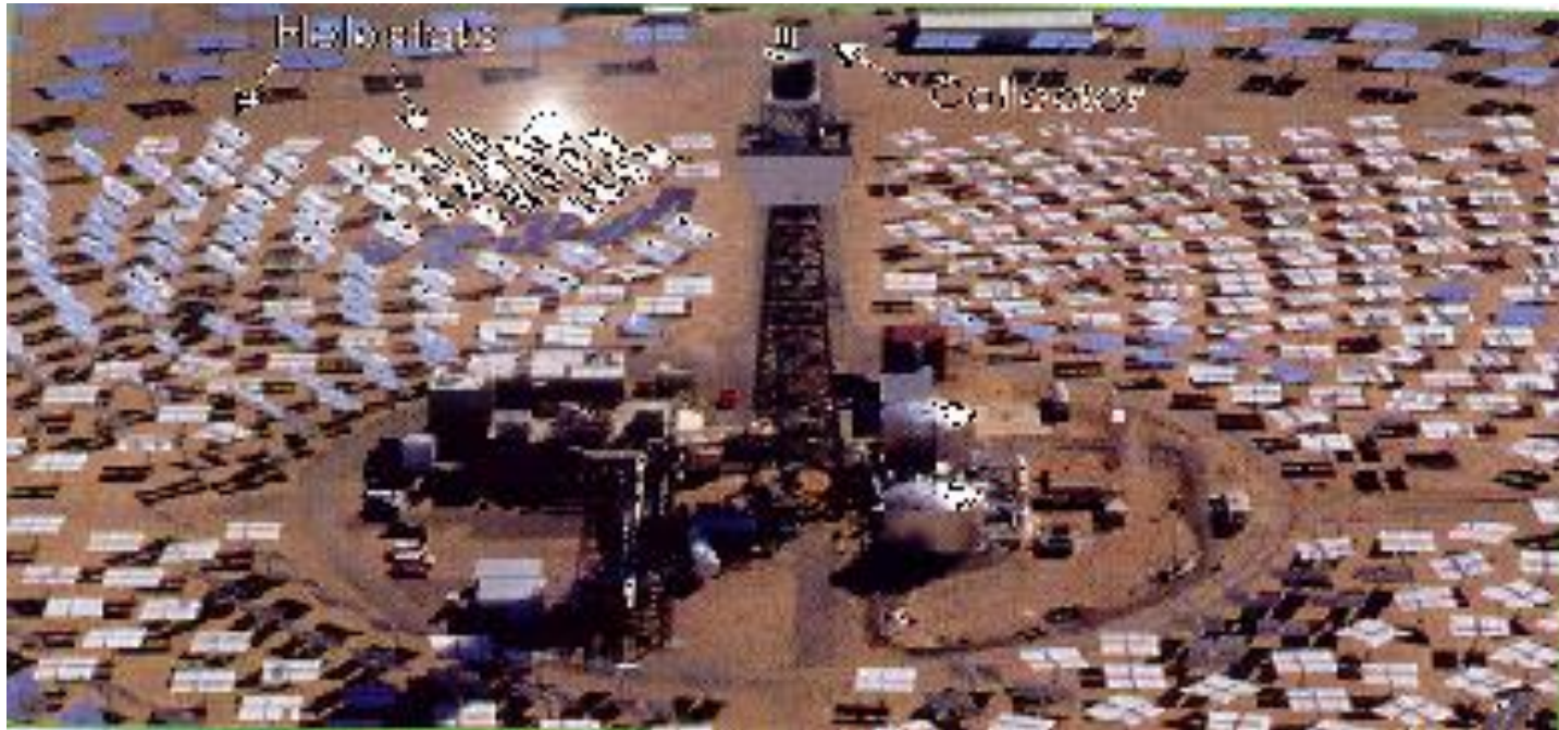
Σχ. 1.26α 10 MW ηλιακός σταθμός, στο Barstow της Καλιφόρνιας.
