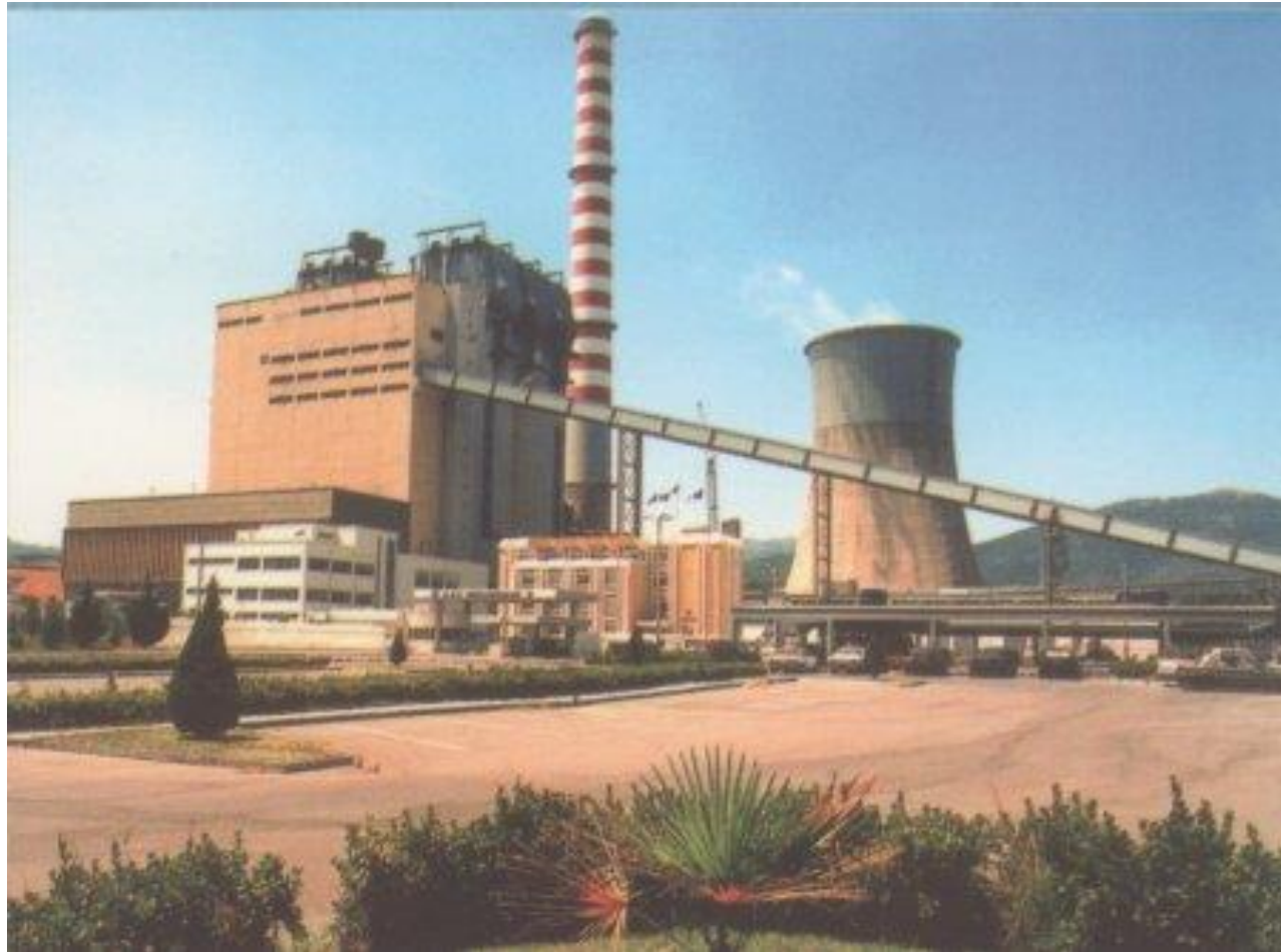
Σχ. 1.8 Γενική άποψη ατμοηλεκτρικού σταθμού στη Μεγαλόπολη.
