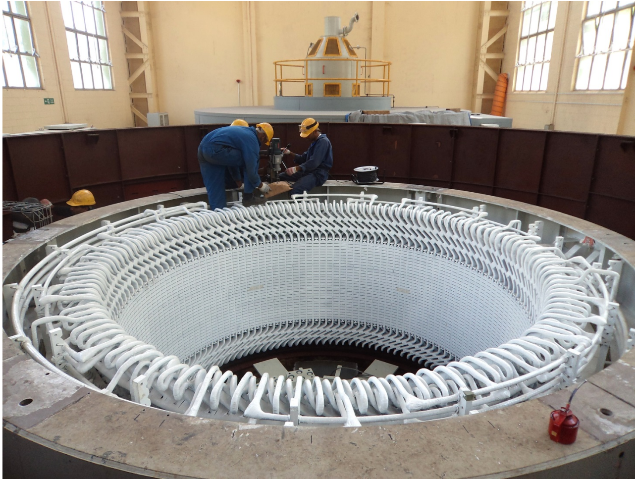
Κατασκευή Στάτη Σύγχρονης Μηχανής Έκτυπων Πόλων [14]
