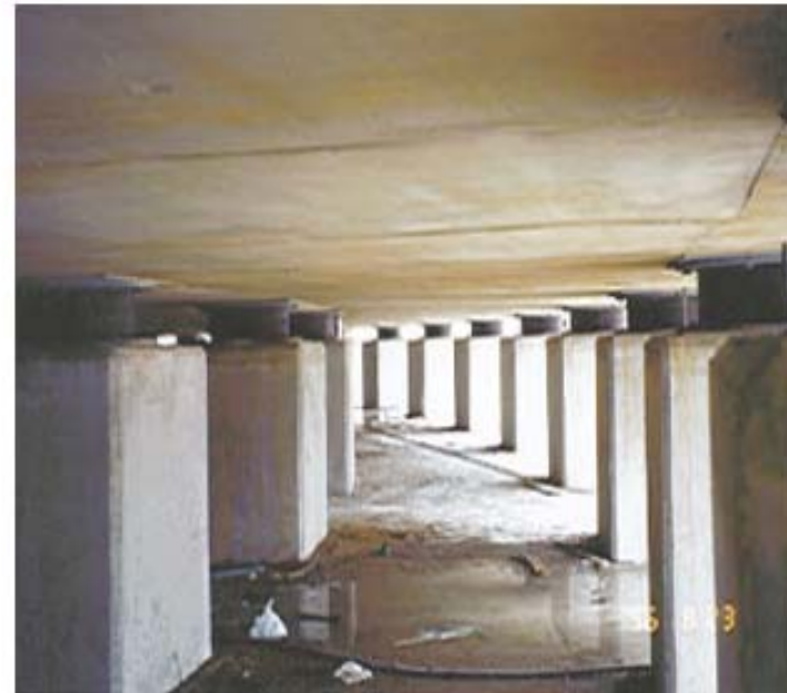
LNG TANKS, INCHON, KOREA
