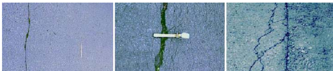
Εικόνα 13 Επίπεδα σοβαρότητας ρωγμών μεταξύ λωρίδων διάστρωσης ή διαπλάτυνσης
