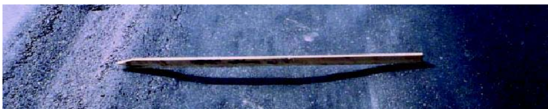
Εικόνα 18 Αυλακώσεις στις τροχιές των τροχών
