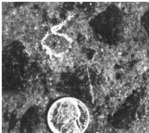
Εικόνα 29 Λείανση αδρανών σε κάποιο οδόστρωμα
