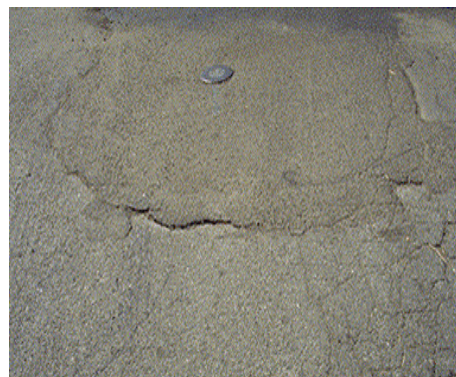
Εικόνα 21 Μεσαίας σοβαρότητας μπαλώματα
