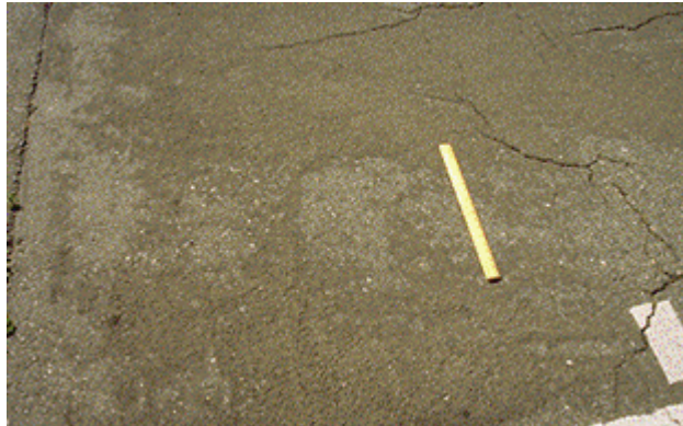
Εικόνα 23 Αποκόλληση αδρανών
