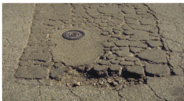
Εικόνα 22 Υψηλής σοβαρότητας τοπικές επισκευές
