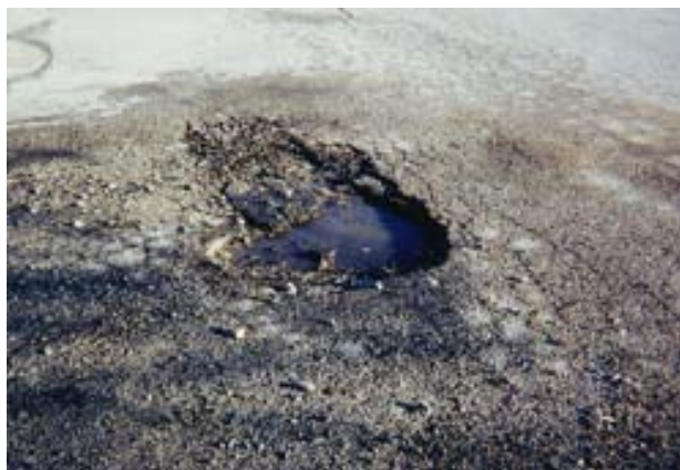
Εικόνα 27 Υψηλής σοβαρότητας λακκούβα σε κάποιο οδόστρωμα
