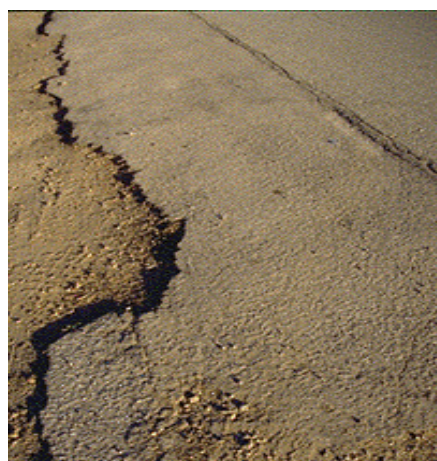
Εικόνα 26 Υψηλής σοβαρότητας αποκόλληση αδρανών
