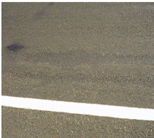
Εικόνα 25 Μεσαίας σοβαρότητας αποκόλληση αδρανών
