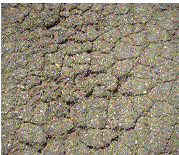
Εικόνα 4 Υψηλής έντασης ρωγμές τύπου αλιγάτορα
