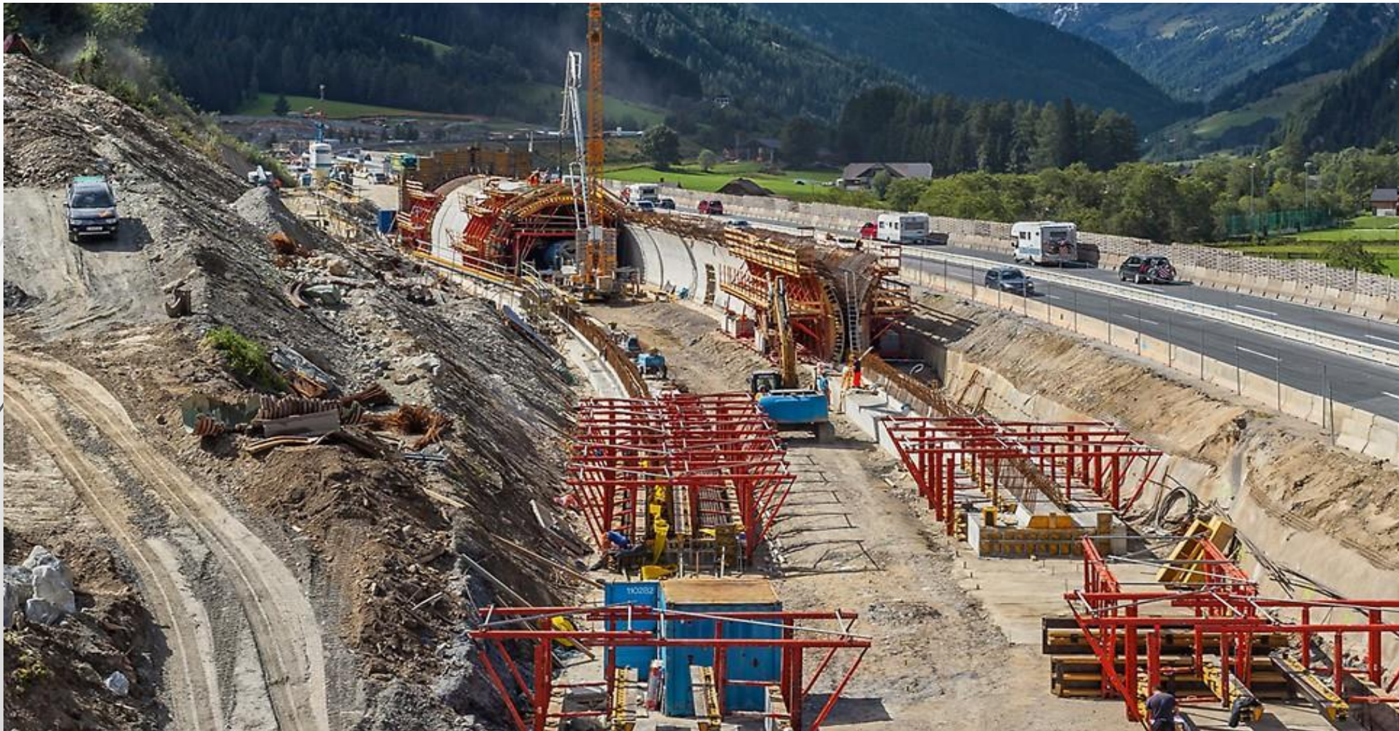
Μέθοδος cut and cover με εκτεταμένο πλάτος μετώπου εργασιών
