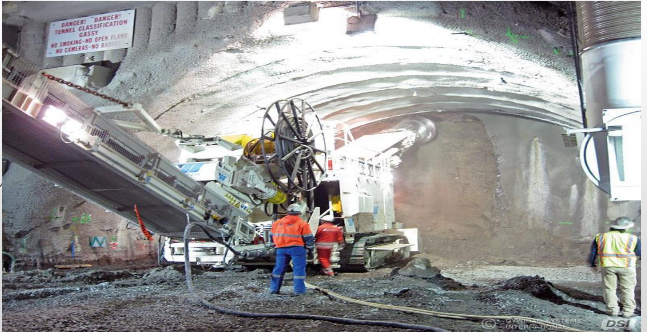
Μηχάνημα σημειακής κοπής (Roadheader)
