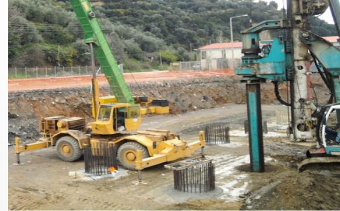
Θεμελίωση με πασσάλους
