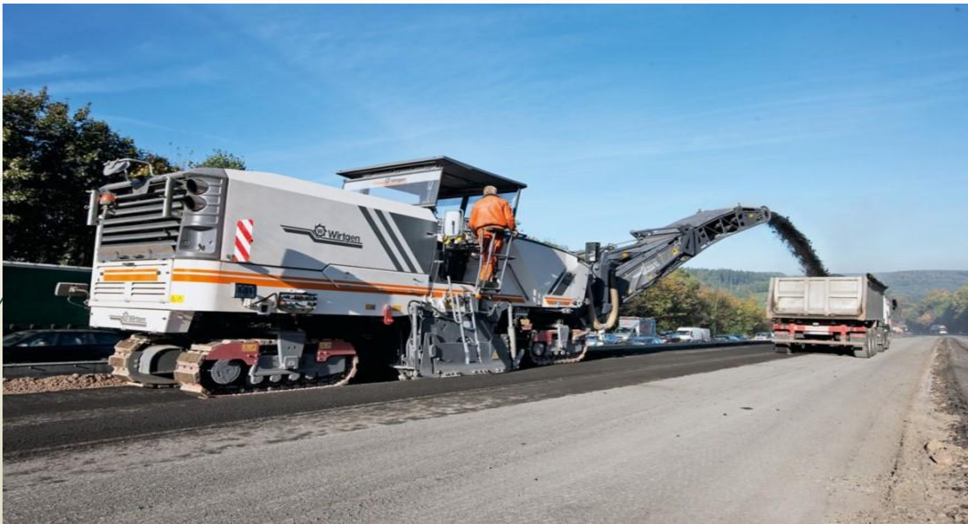
Μηχάνημα για την αφαίρεση της επιφανειακής ασφαλτικής στρώσης
