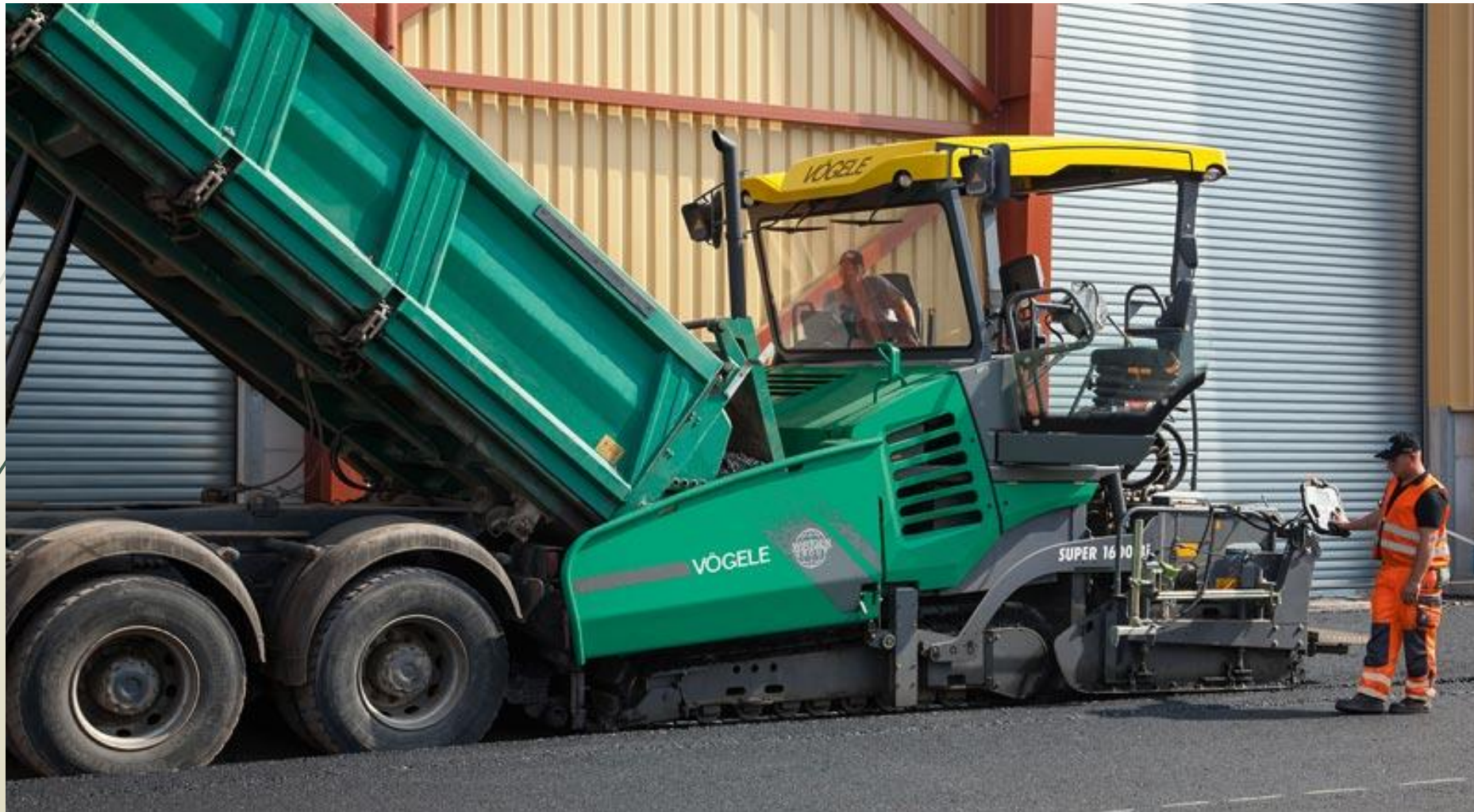
Μηχάνημα διάστρωσης ασφαλτοτάπητα
