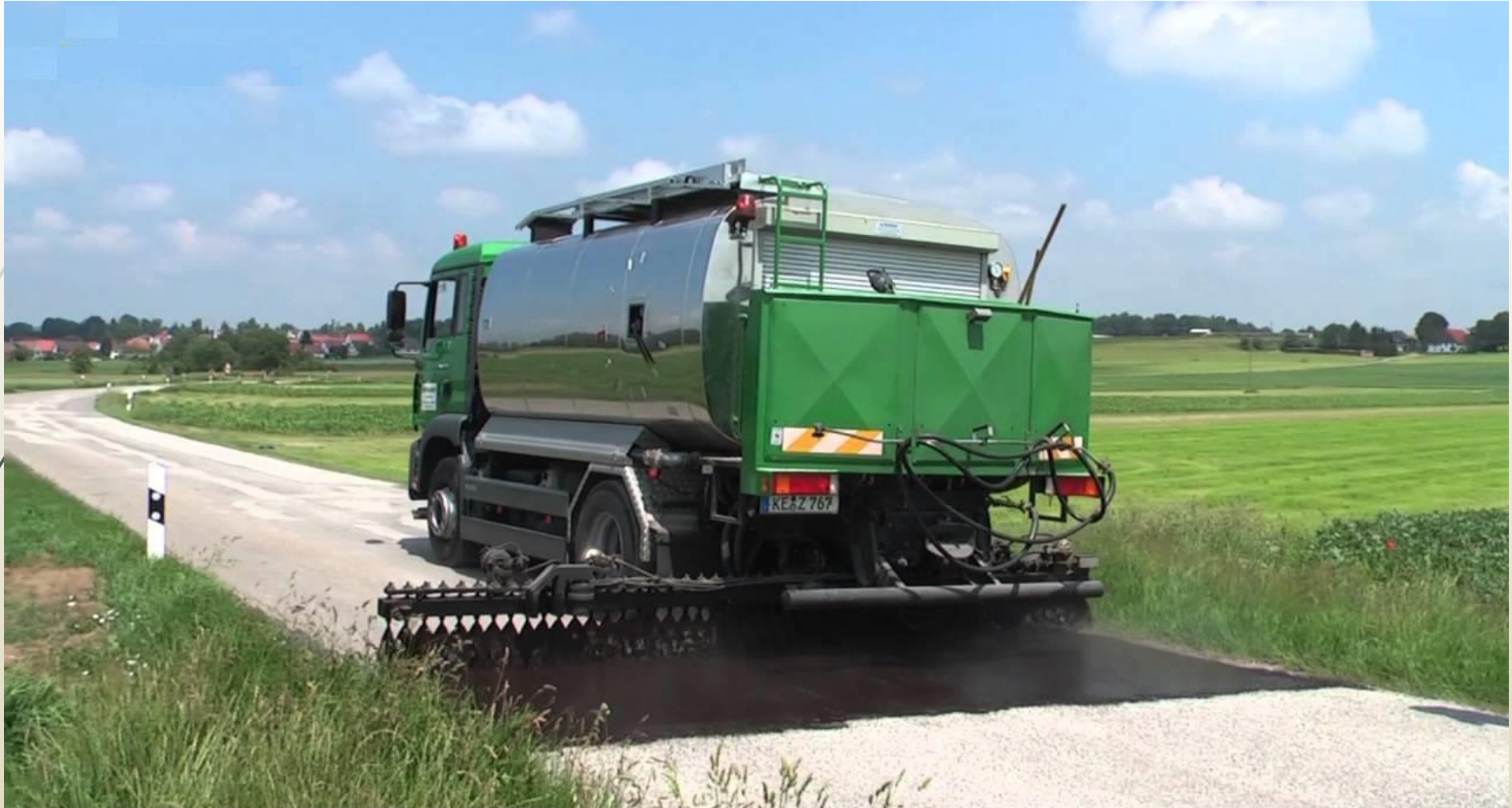
Όχημα ψεκασμού προεπάλειψης ή συγκολλητικής επάλειψης
