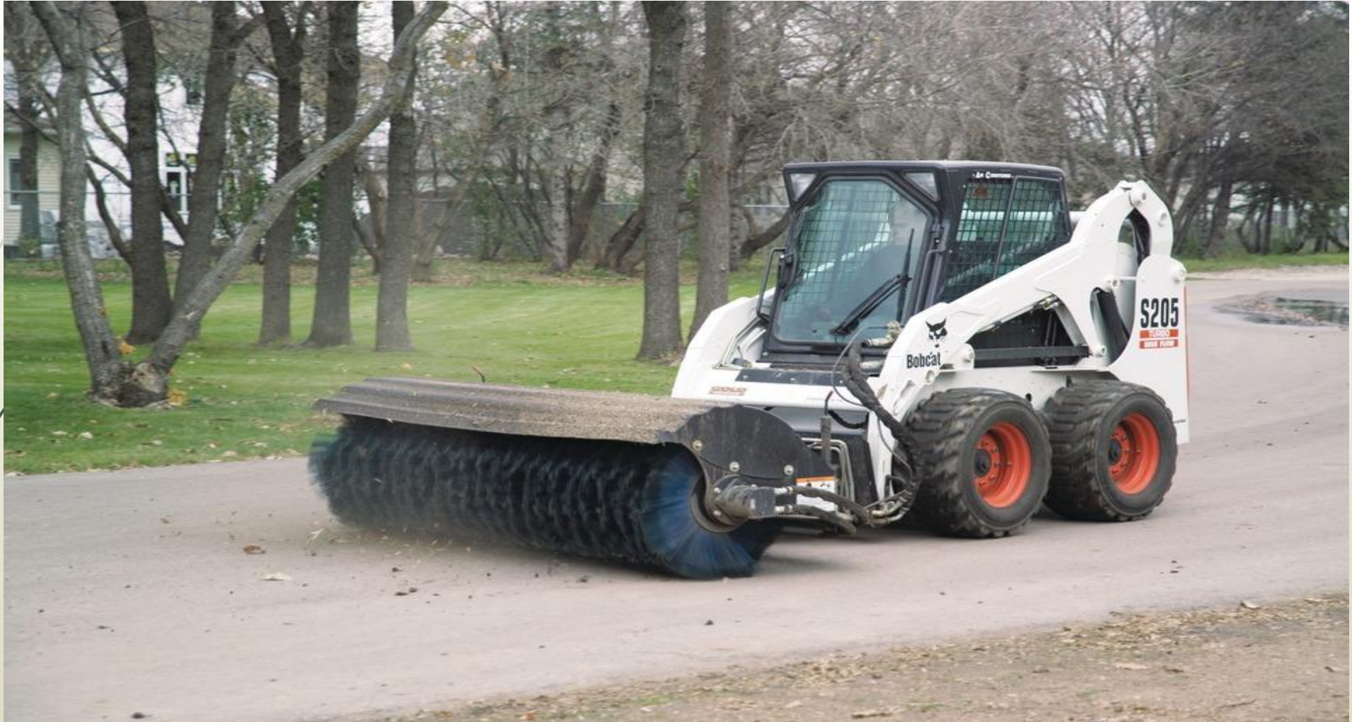
Όχημα καθαρισμού του οδοστρώματος πριν την ασφαλτόστρωση
