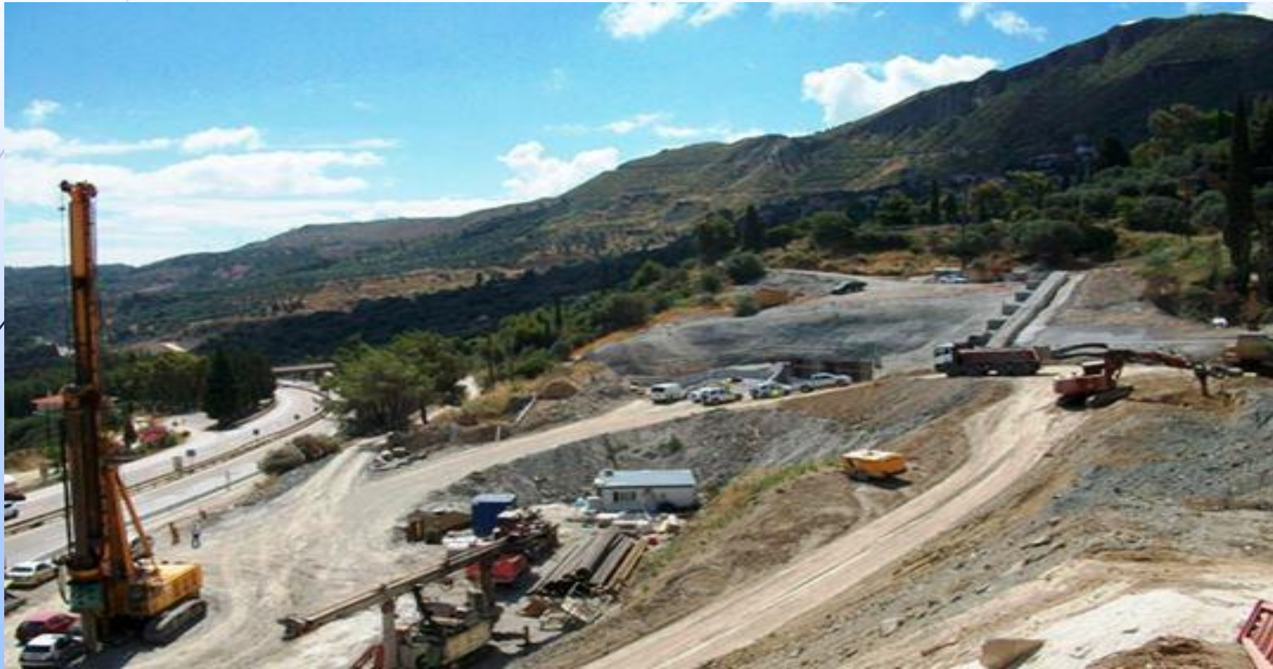
Εργοτάξιο Ολυμπίας οδού, (Άκτωρ ΑΤΕ)
