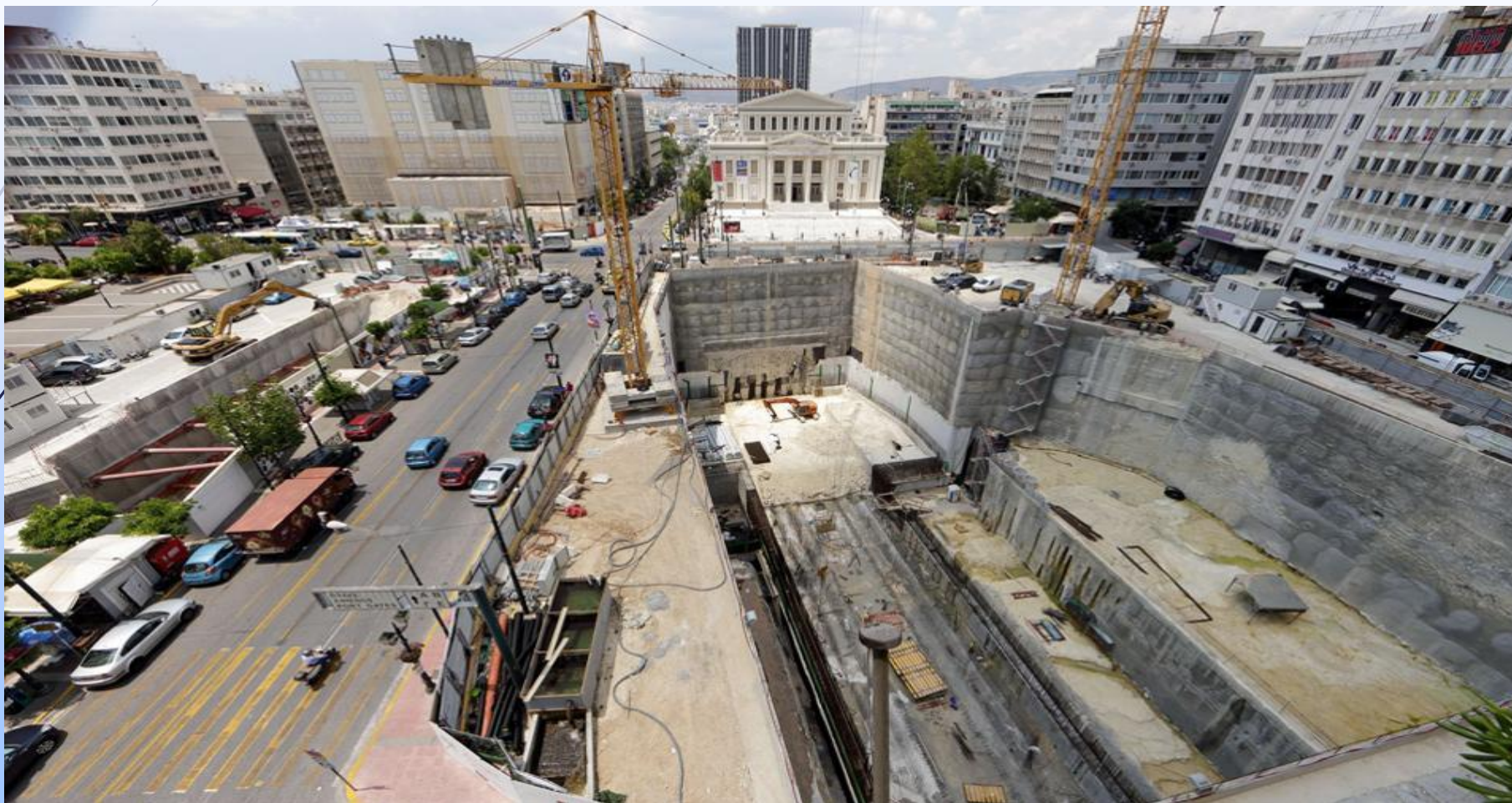
Εργοτάξιο Αττικό Μετρό (Σταθμός Πειραιά)
