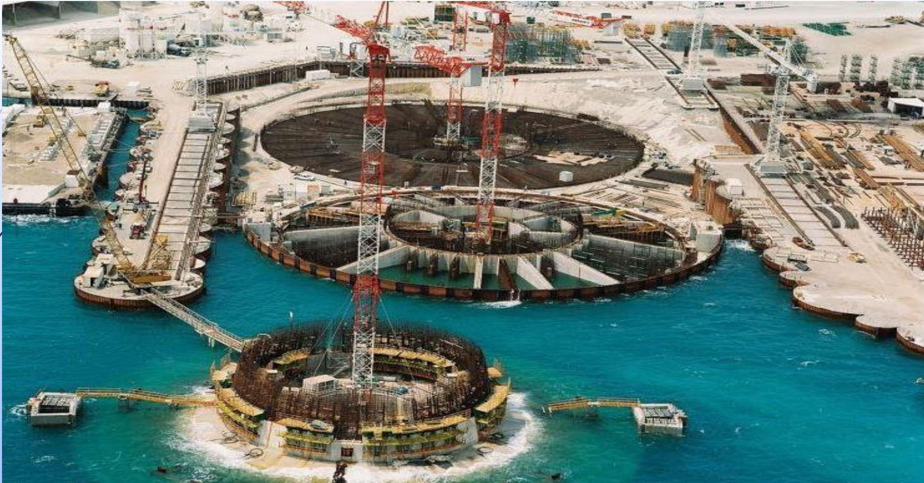
Γέφυρα Ρίου – Αντιρρίου (Vinci S.A.)
