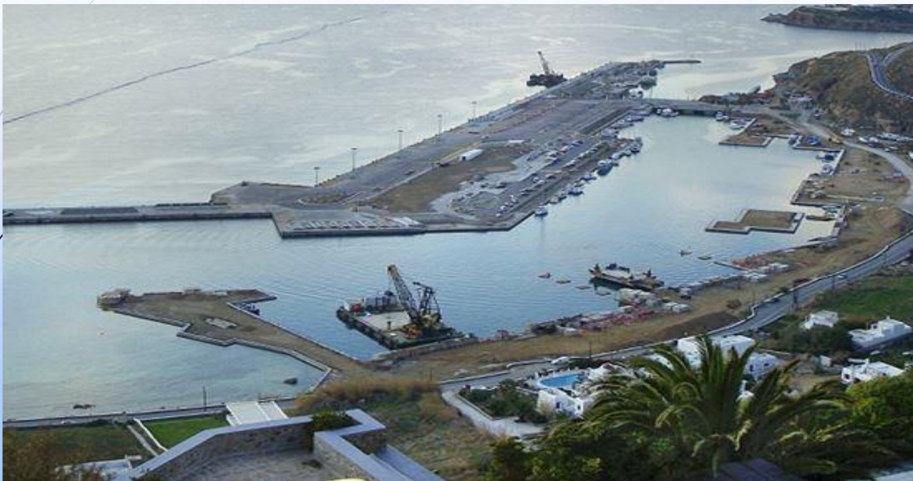
Εργοτάξιο νέου λιμένα Μυκόνου, (Άκτωρ ΑΤΕ)
