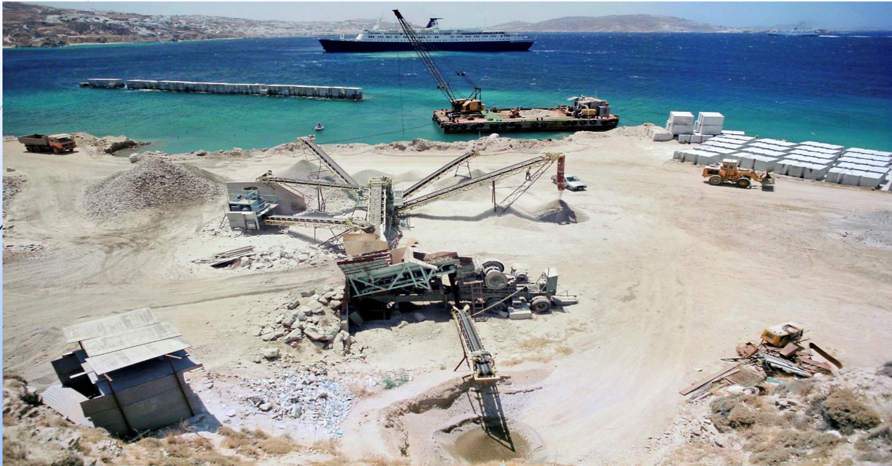
Εργοτάξιο νέου λιμένα Σάμου, (Κόμβος ΑΤΕ)
