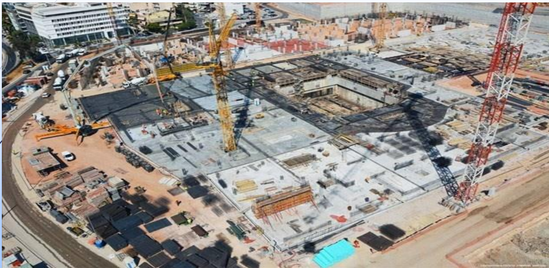
Εργοτάξιο Κέντρου Πολιτισμού Ιδρύματος Σταυρός Νιάρχος, (ΤΕΡΝΑ ΑΕ – Impregilo)
