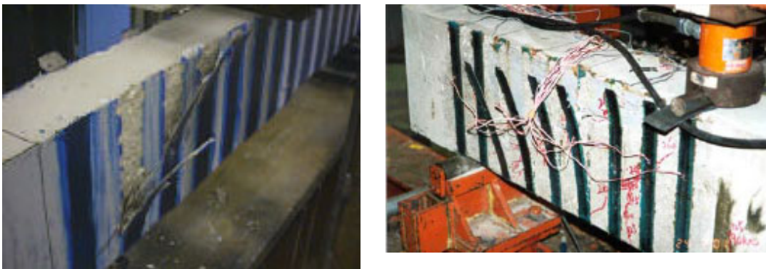
Σχ. 5.5 Αποκόλληση οπλισμών διάτμησης.
