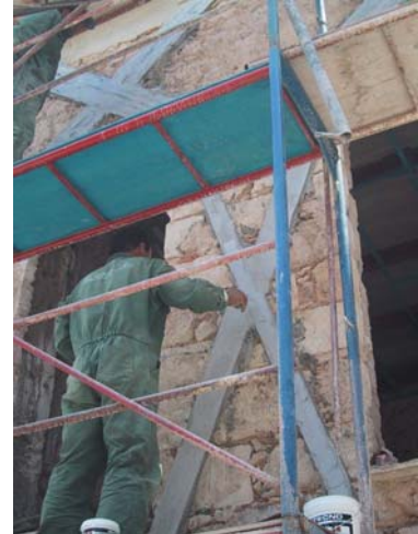
Εφαρμογή επιπεδωτικού κονιάματος για την επικόλληση ελασμάτων σε στοιχεία τοιχοποιίας
