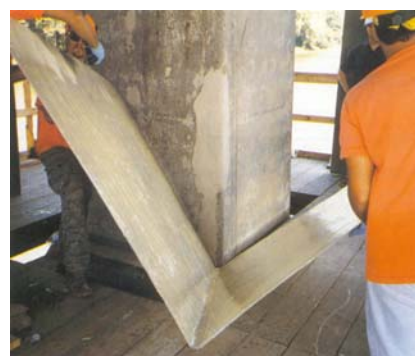
Σχ. 2.12 Παραδείγματα εφαρμογής προκατασκευασμένων στοιχείων. (α) Γωνιές, (β)-(γ) εφαρμογή γωνιών για την ενίσχυση δοκού σε διάτμηση, (δ) εφαρμογή μανδύα μορφής κελύφους, (ε) εφαρμογή μανδύα σε τεμάχια.
