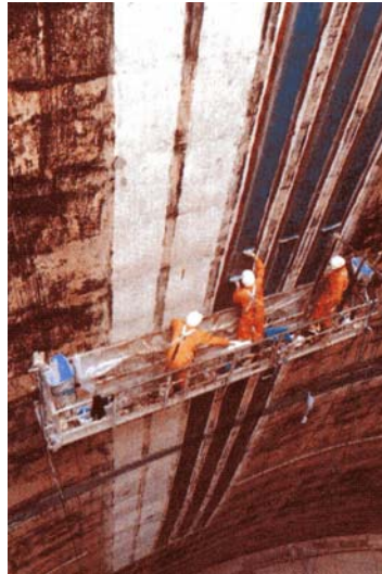
Ενίσχυση του κελύφους πύργου ψύξης με υφάσματα συνθέτων υλικών
