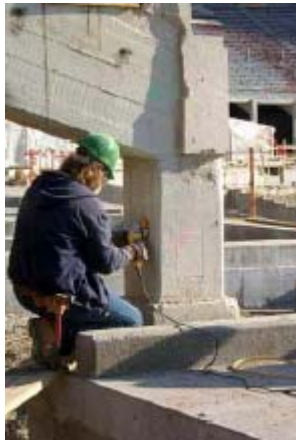
Σχ. 7.13 Προετοιμασία επιφανειών: (α) Τρίψιμο, (β) σχολαστικός καθαρισμός και (γ) εξομάλυνση.
