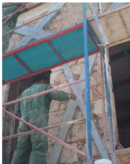
Σχ. 8.4 Χιαστί διάταξη λωρίδων σε τοιχοποιία.
