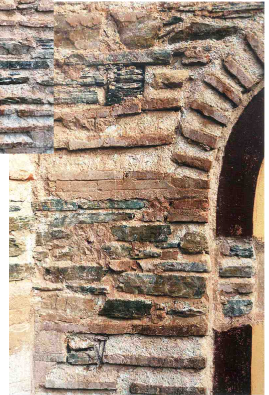
Μονή Βατοπεδίου, Καθολικό : αποξηλώσεις, τεκμηρίωση και αναπαράσταση της αρχικής μορφής
