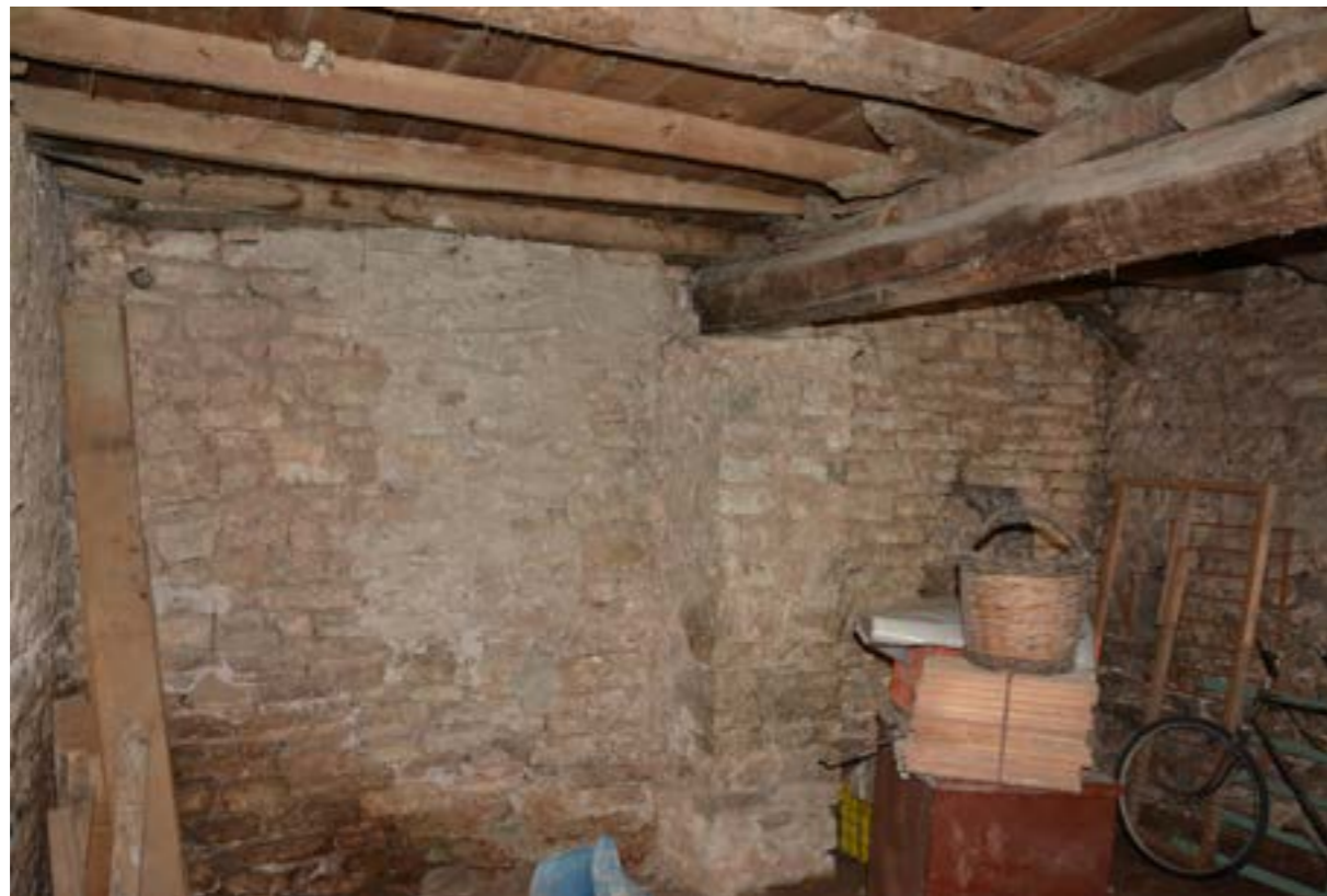
Εικόνα 11 : Άποψη Ισογείου (Φωτ.Σταυρος Μαμαλούκος)
