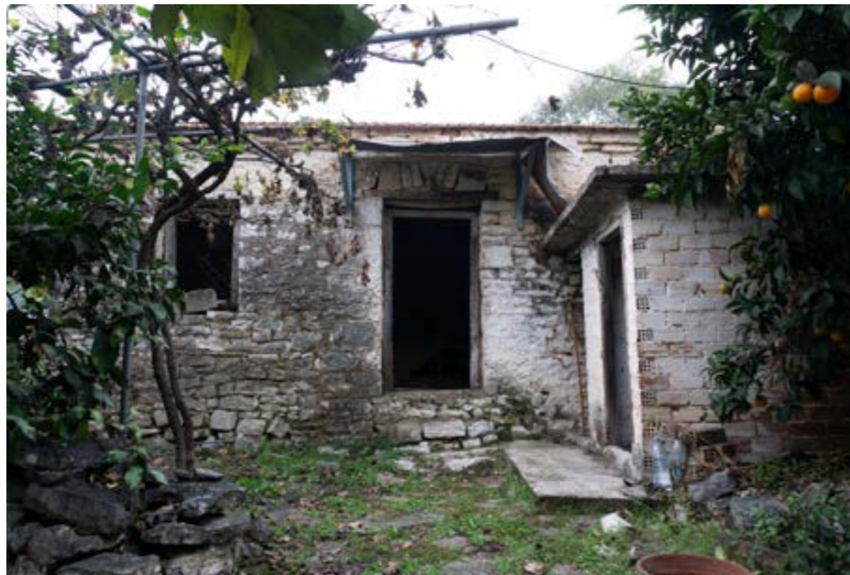
Εικόνα 31 : Εξωτερική Άποψη Αχουριού (Φωτ.Σταυρος Μαμαλούκος)
