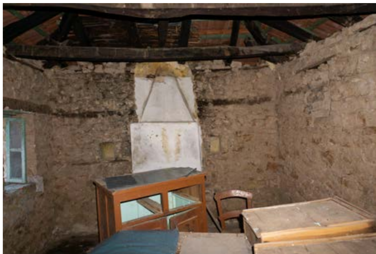
Εικόνα 25 : Εσωτερική Άποψη Μαγειρείου (Φωτ.Σταυρος Μαμαλούκος)
