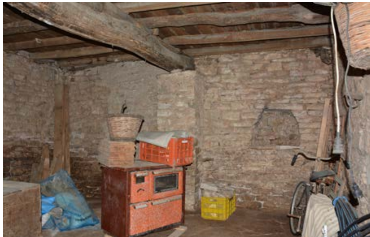
Εικόνα 9 : Άποψη Ισογείου (Φωτ.Σταυρος Μαμαλούκος)
