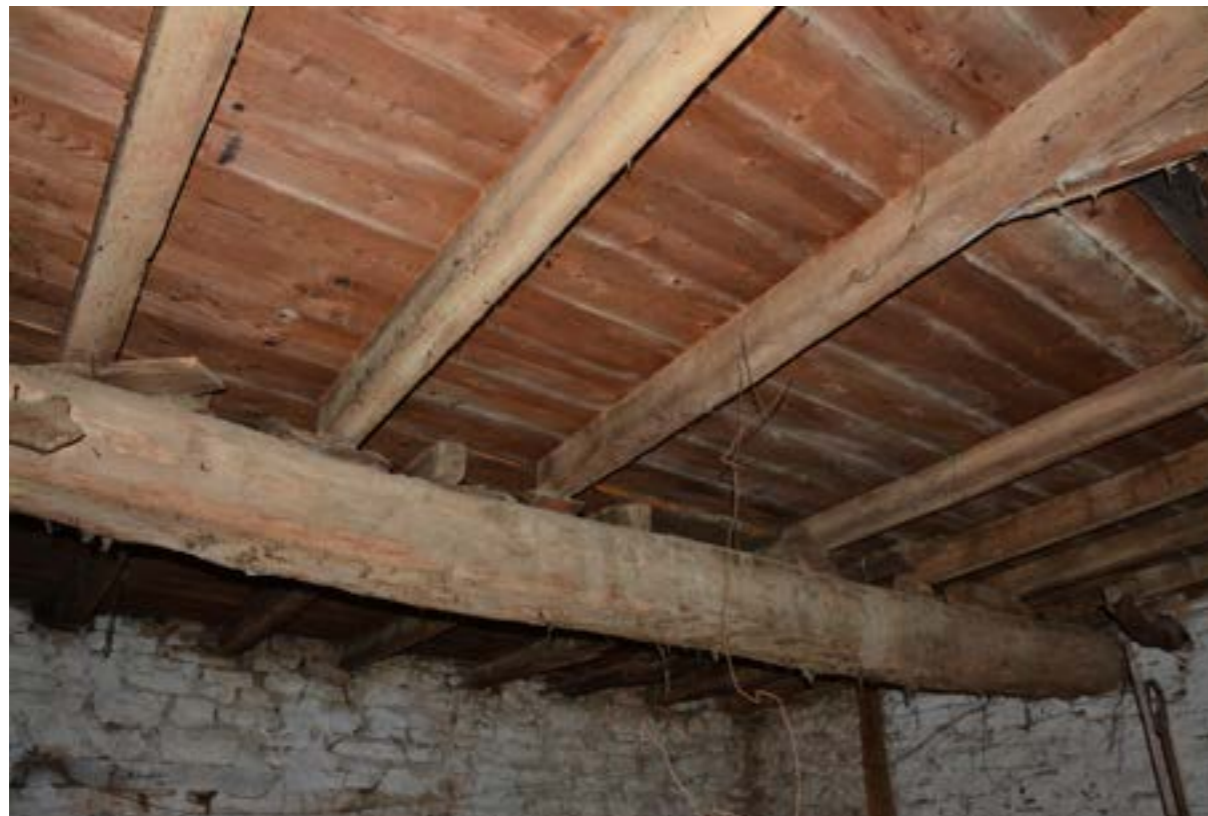
Εικόνα 7 : Άποψη Ισογείου (Φωτ.Σταυρος Μαμαλούκος)
