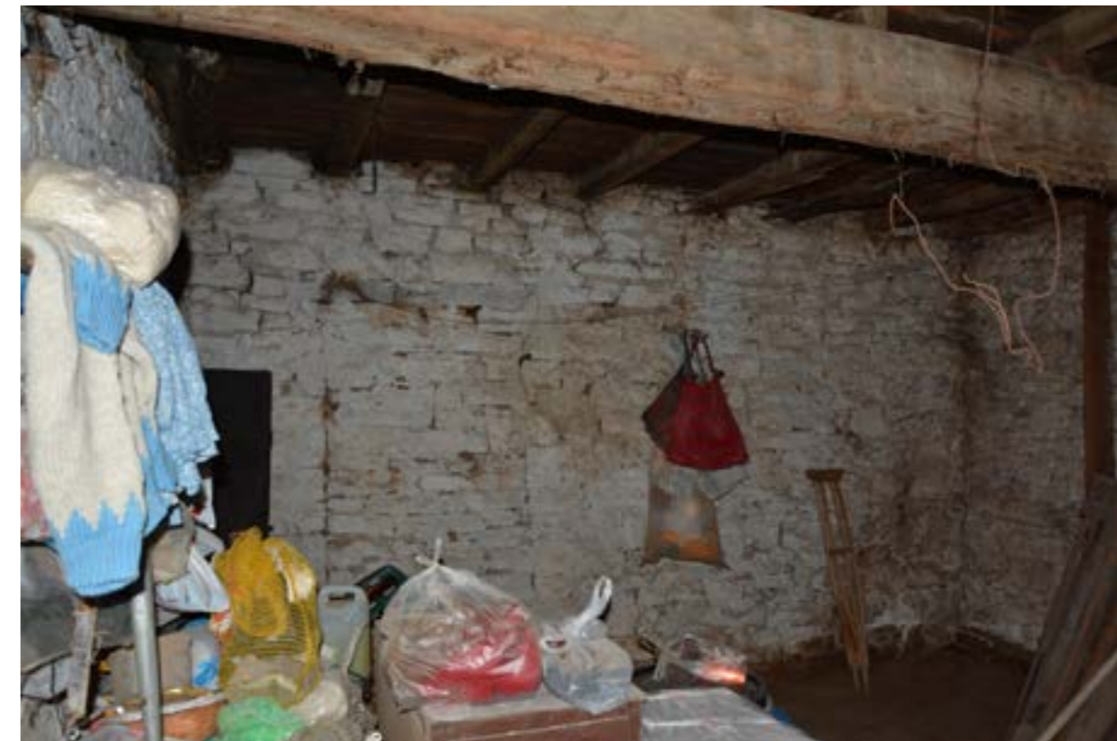
Εικόνα 8 : Άποψη Ισογείου (Φωτ.Σταυρος Μαμαλούκος)
