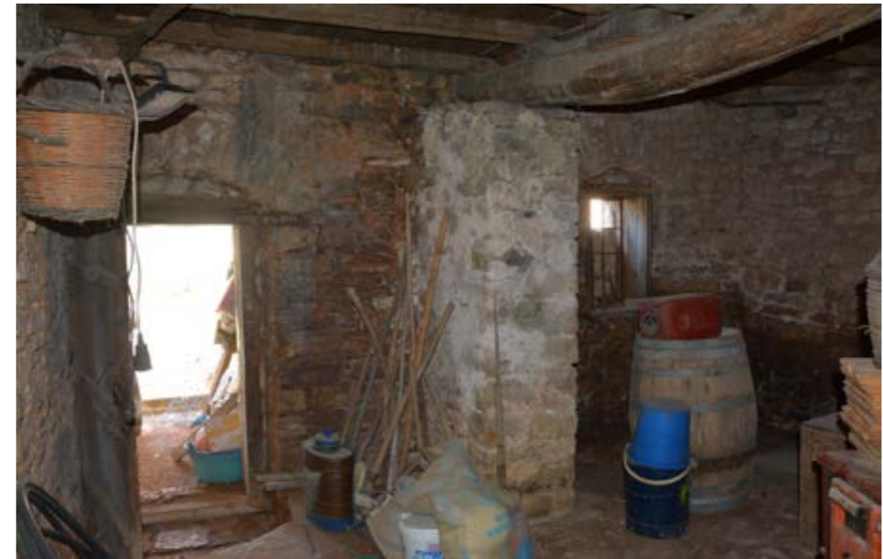
Εικόνα 10 : Άποψη Ισογείου (Φωτ.Σταυρος Μαμαλούκος)
