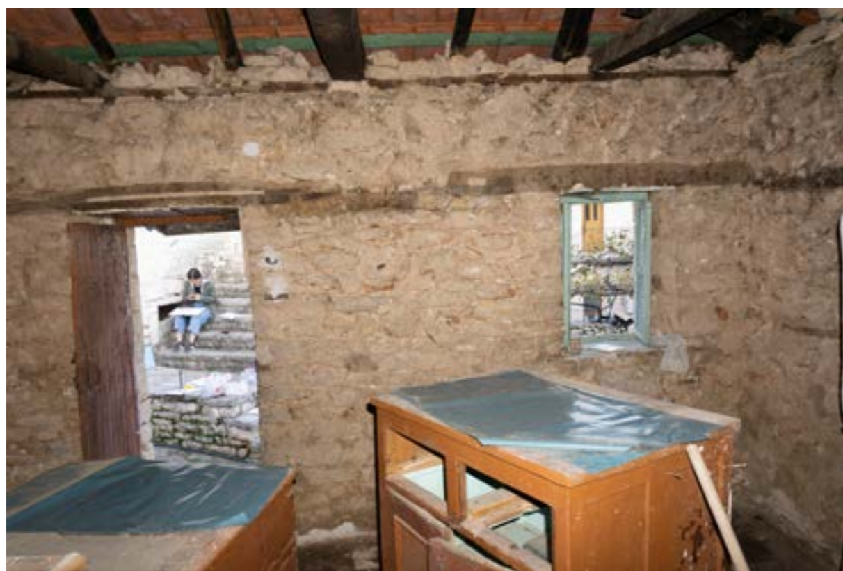
Εικόνα 27 : Εσωτερική Άποψη Μαγειρείου (Φωτ.Σταυρος Μαμαλούκος)
