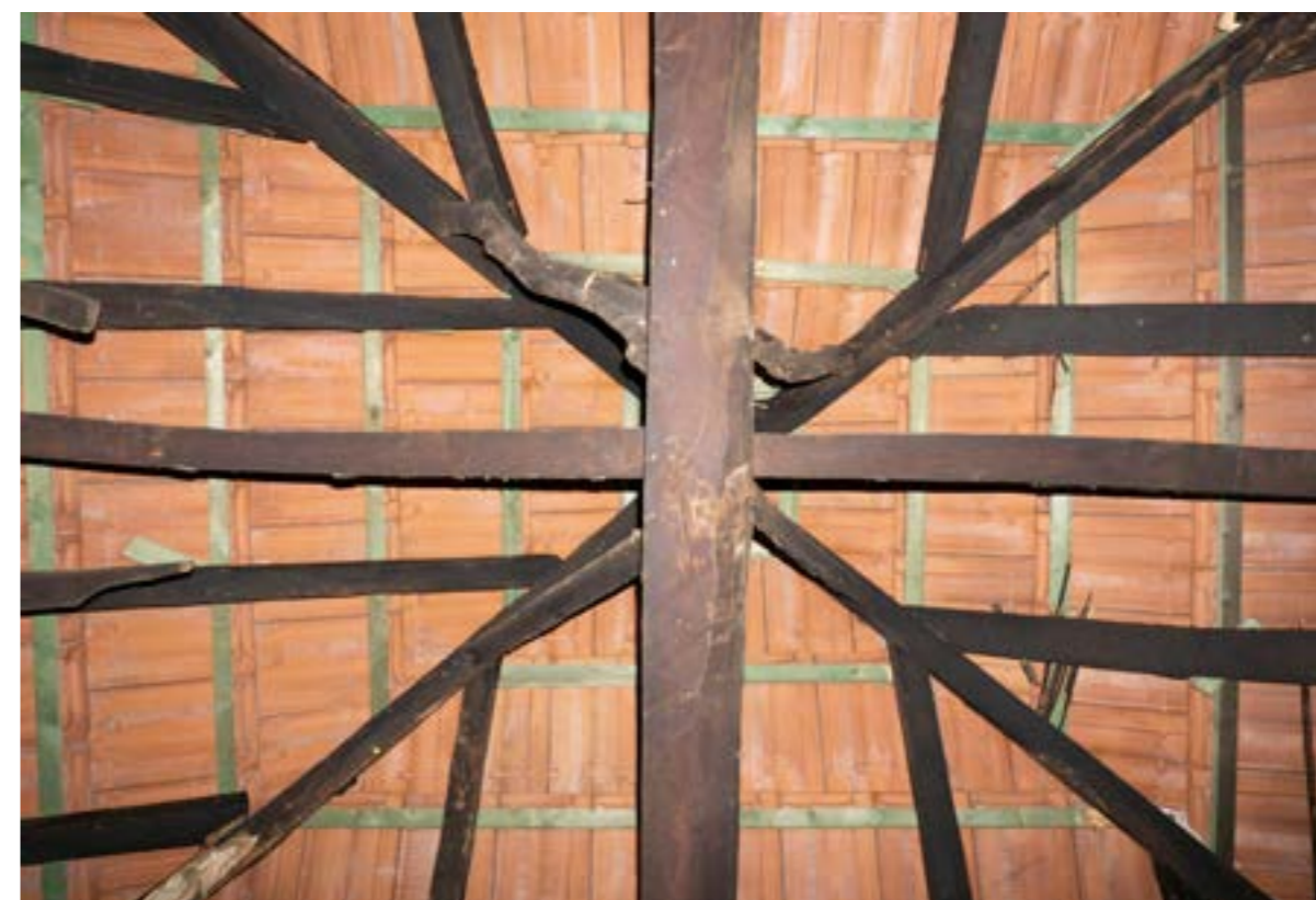
Εικόνα 28 : Εσωτερική Άποψη Μαγειρείου (Φωτ.Σταυρος Μαμαλούκος)
