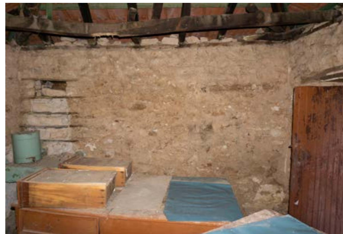
Εικόνα 26 : Εσωτερική Άποψη Μαγειρείου (Φωτ.Σταυρος Μαμαλούκος)
