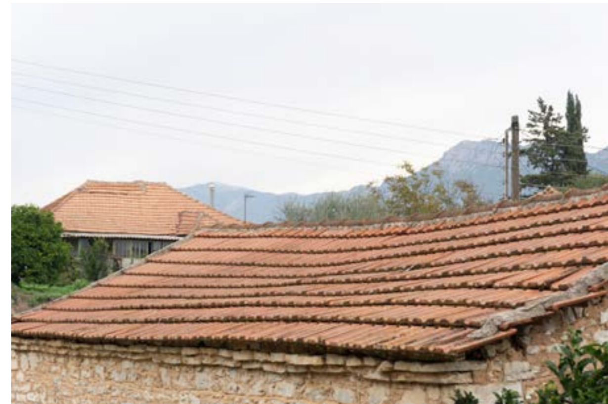
Εικόνα 32 : Εξωτερική Άποψη Αχουριού (Φωτ.Σταυρος Μαμαλούκος)
