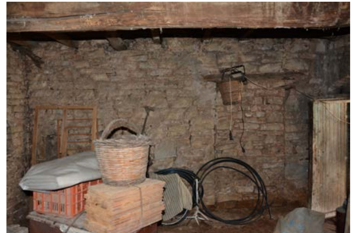
Εικόνα 12 : Άποψη Ισογείου (Φωτ.Σταυρος Μαμαλούκος)
