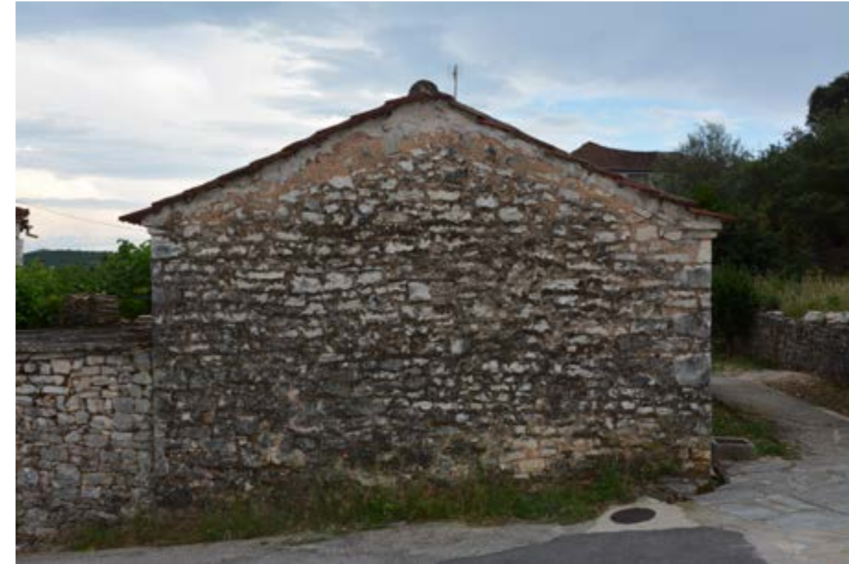
Εικόνα 30 : Εξωτερική Άποψη Αχουριού (Φωτ.Σταυρος Μαμαλούκος)
