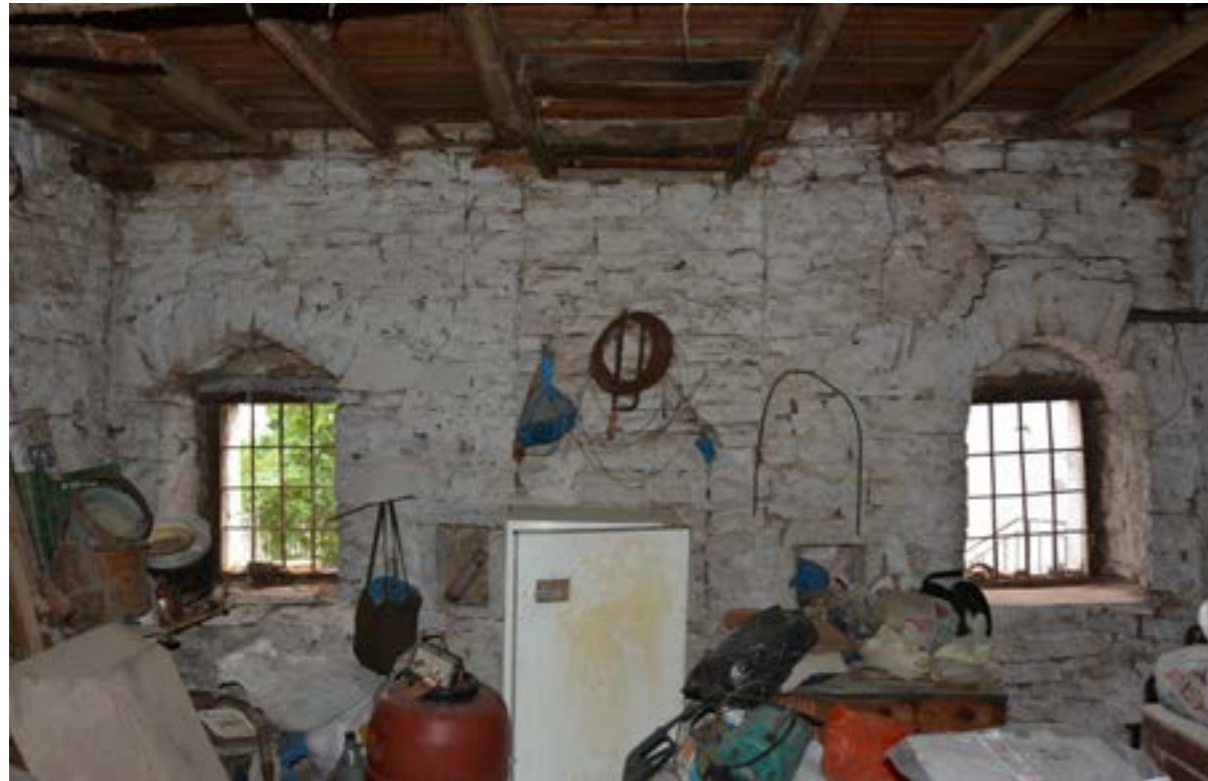
Εικόνα 5 : Άποψη Ισογείου (Φωτ.Σταυρος Μαμαλούκος)
