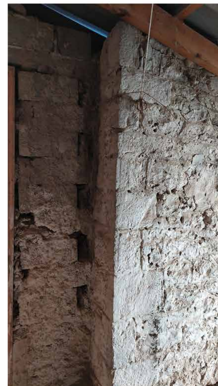
Εικ.Ορ. 31 Τοίχιο πλησίον της Θ2.06
