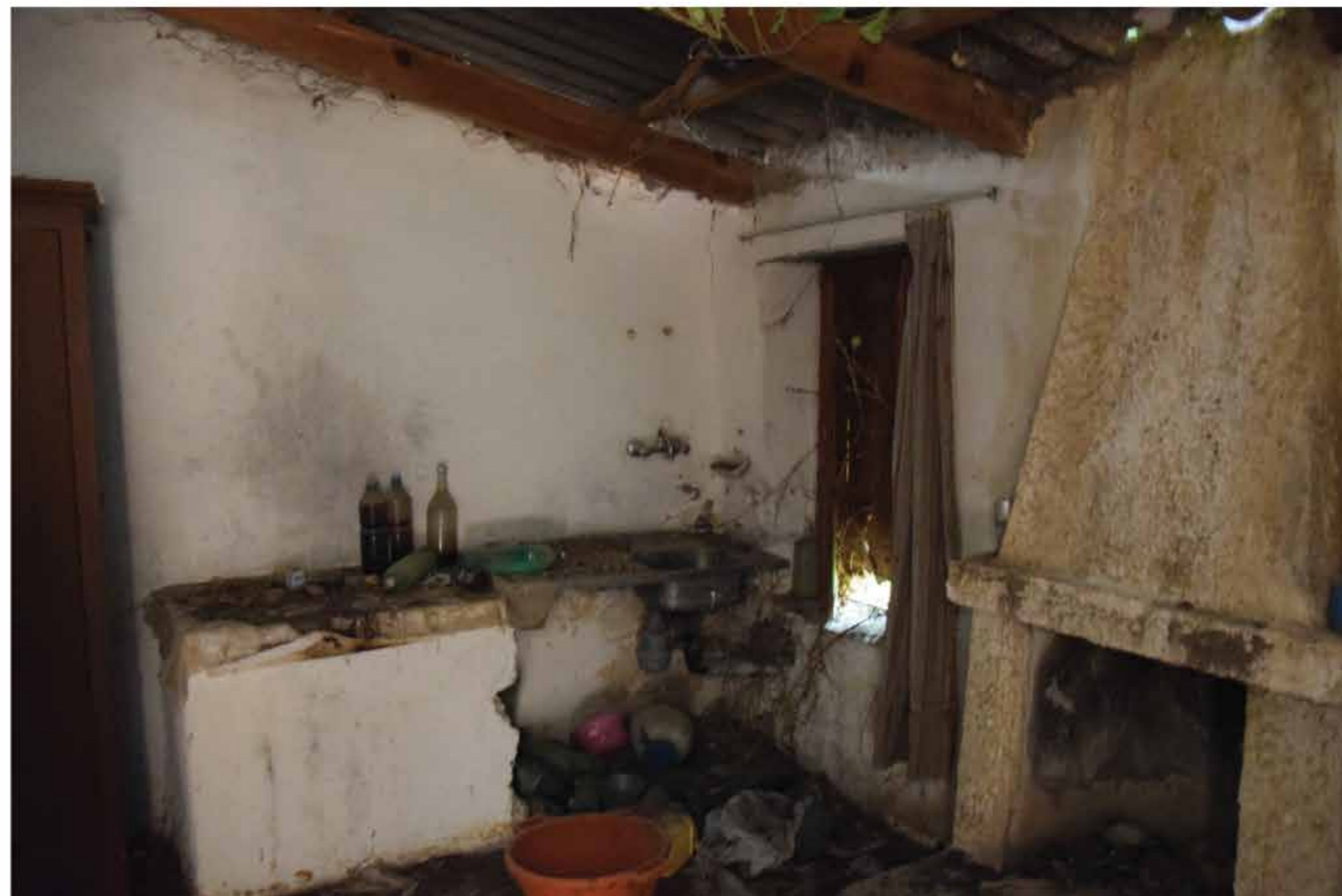
Εικ.Ορ. 26 Άποψη του 2.06
