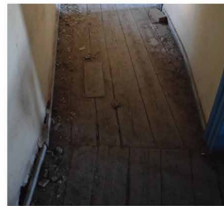
Εικ.Ορ.04 Λεπτομέρεια πατώματος
