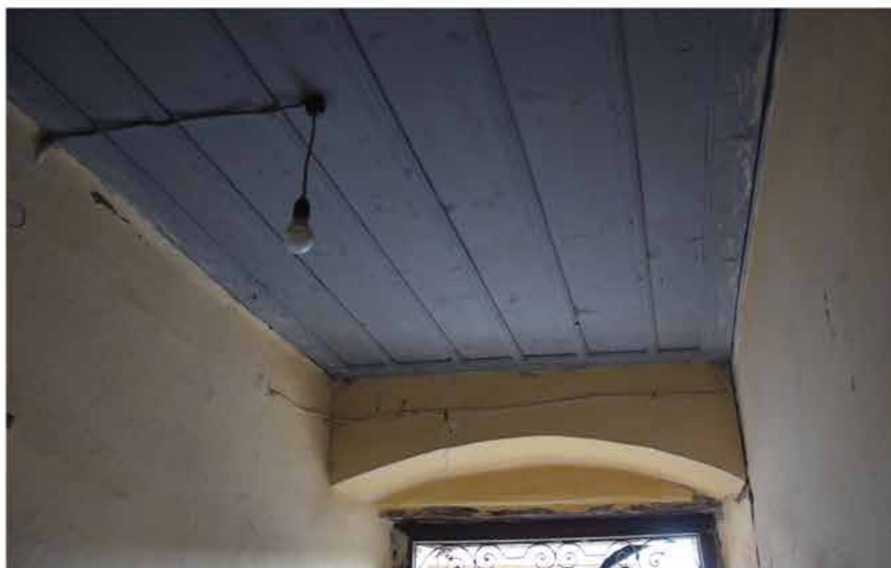
Εικ.Ισ. 05 Άποψη οροφής
