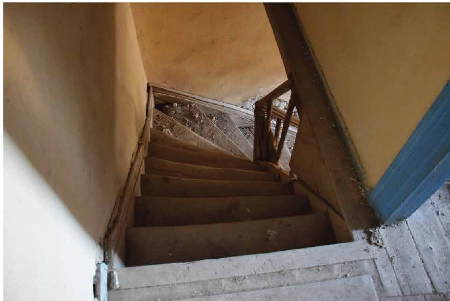
Εικ.Ορ.02 Η σκάλα από τον όροφο
