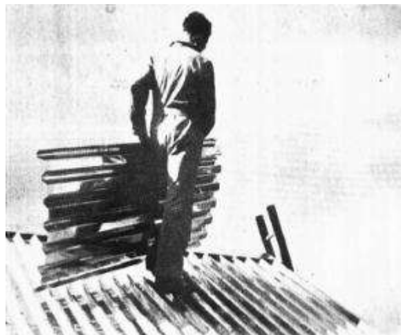
Αυλακωτά φύλλα από αλουμίνιο για επικάλυψη στεγών.
