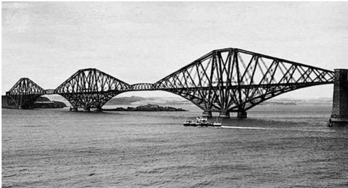
Γέφυρα στο Forth της Σκωτίας. Κατασκευάστηκε το 1890 και αποτελείται από τρία σωληνωτά βόθρα που δημιουργούν με προβόλους δύο κύρια ανοίγματα μήκους 521 μ. το καθένα.
