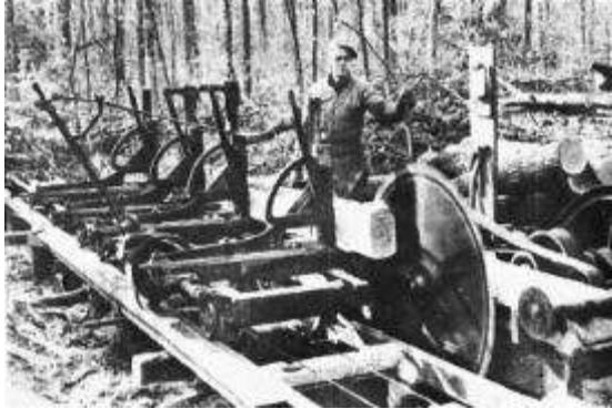
Δισκοπρίονο τοποθετημένο στο ύπαιθρο για την αρχική κοπή μεγάλων κορμών.
