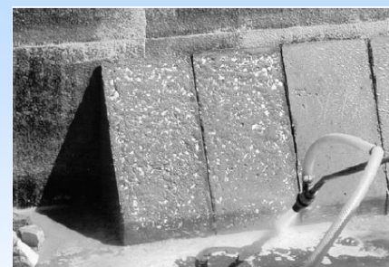
Εκτράχυνση με Αμμοβολή
