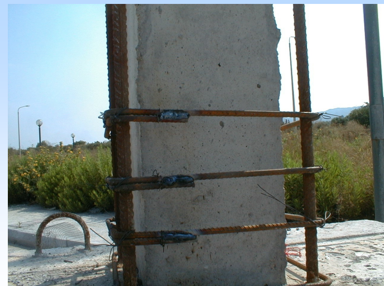
Ηλεκτροσυγκόλληση Άκρων Συνδετήρων Μανδύα
