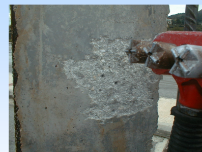
Προετοιμασία Επιφάνειας με Αεροματσάκονο
