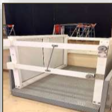
Εικόνα 169. Αναβατήριο κατακόρυφης κίνησης για πρόσβαση στη σκηνή του χώρου εκδηλώσεων (Ε.Ε.Ε.ΕΚ. Ελευσίνας)
