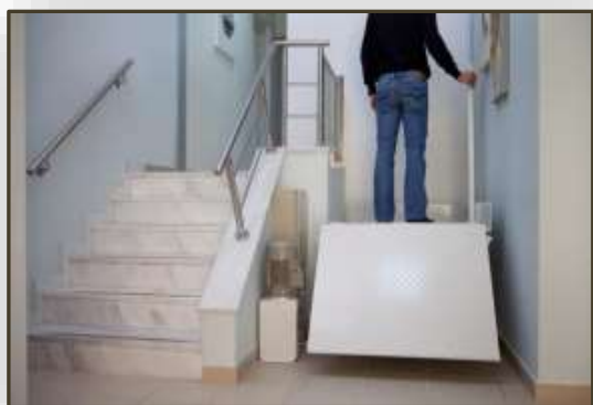
Εικόνα 18. Αναβατόριο κατακόρυφης κίνησης με πλατφόρμα (Δημουλά, κ.ά., 2023)
