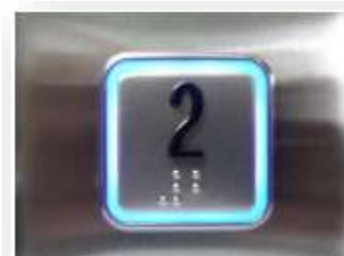
Εικόνα 84. Μπουτόν ανελκυστήρα σε γραφή braille με φωτεινή ένδειξη (Δημουλά, κ.ά., 2023)
