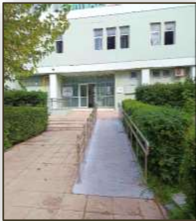
Εικόνα 16. Ράμπα εισόδου σε κτήριο σχολείου με διπλούς χειρολισθήρες (3 ο ΕΠΑ.Λ. Αθήνας)
