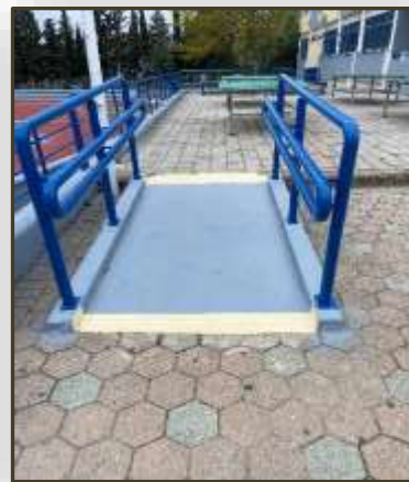
Εικόνα 17. Ράμπα με διπλούς χειρολισθήρες (5 ο Γυμνάσιο Ξάνθης)
