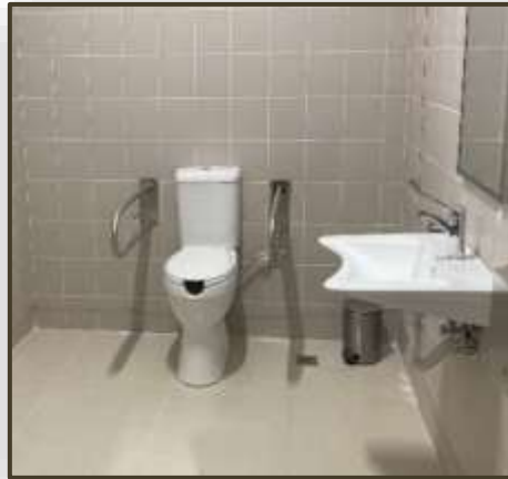
Εικόνα 173. Προσβάσιμος χώρος υγιεινής (2 ο Γυμνάσιο Λευκάδας)
