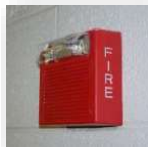
Εικόνα 62. Σύστημα ειδοποίησης πυρκαγιάς (Δημουλά, κ.ά., 2023)
