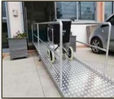
Εικόνα 15. Κατάλληλα υλικά κατασκευής ραμπών (Δημουλά, κ.ά., 2023)
