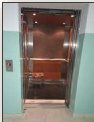
Εικόνα 87. Ανελκυστήρας (1 ο Δημοτικό σχολείο Αρχάνων Ηρακλείου Κρήτης)
