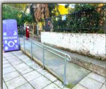
Εικόνα 13. Ράμπα μόνιμη (Ε.Ε.Ε.ΕΚ. Μαθητών με Προβλήματα Όρασης και Πολλαπλές Αναπηρίες)
