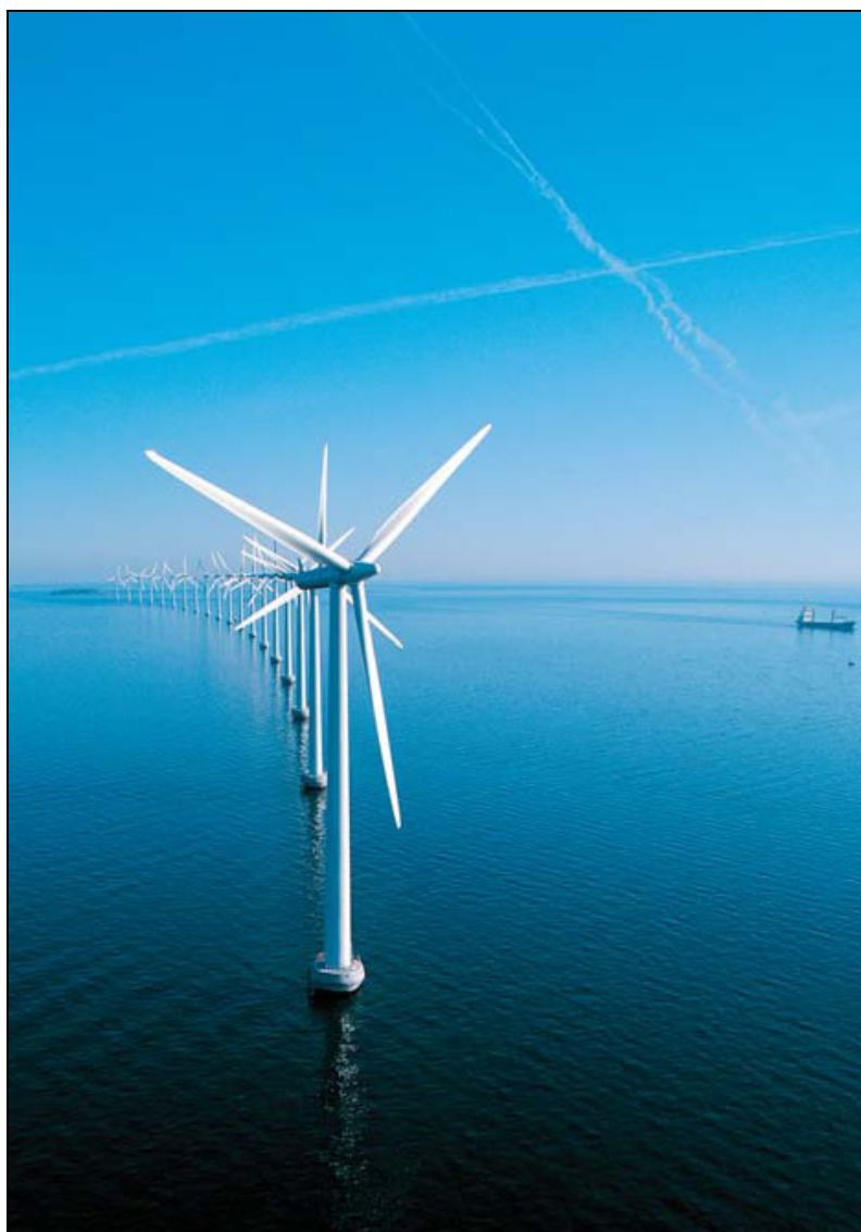
Εικόνα 2: Ανεμοκινητήρες των 2 MW σε ενδοθαλάσσιο αιολικό πάρκο των 40 MW στην Δανία.
