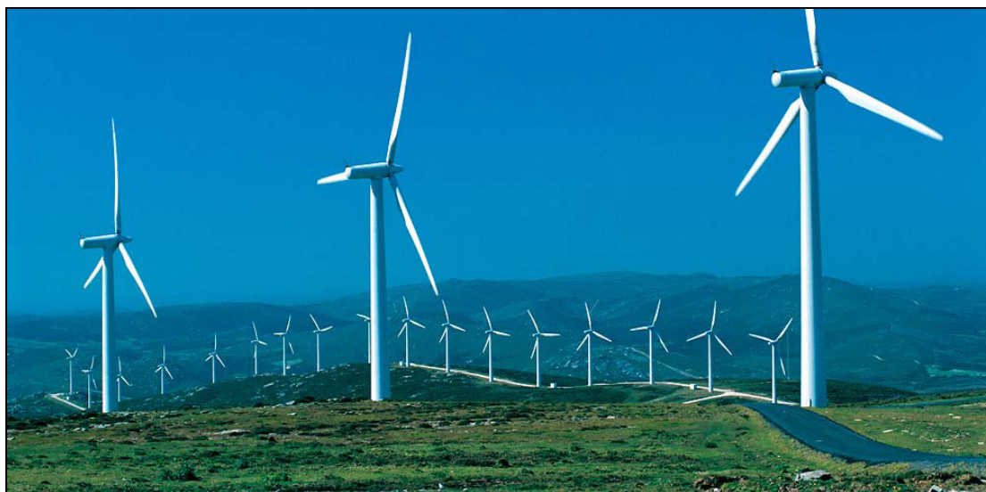
Εικόνα 1. Εγκατάσταση αιολικού πάρκου 39.6 MW στην Ισπανία.
