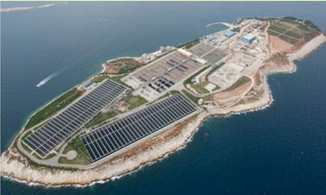
Εγκατάσταση Επεξεργασίας Λυμάτων στην Ψυτάλεια (πηγή: http://www.ypeka.gr ).
