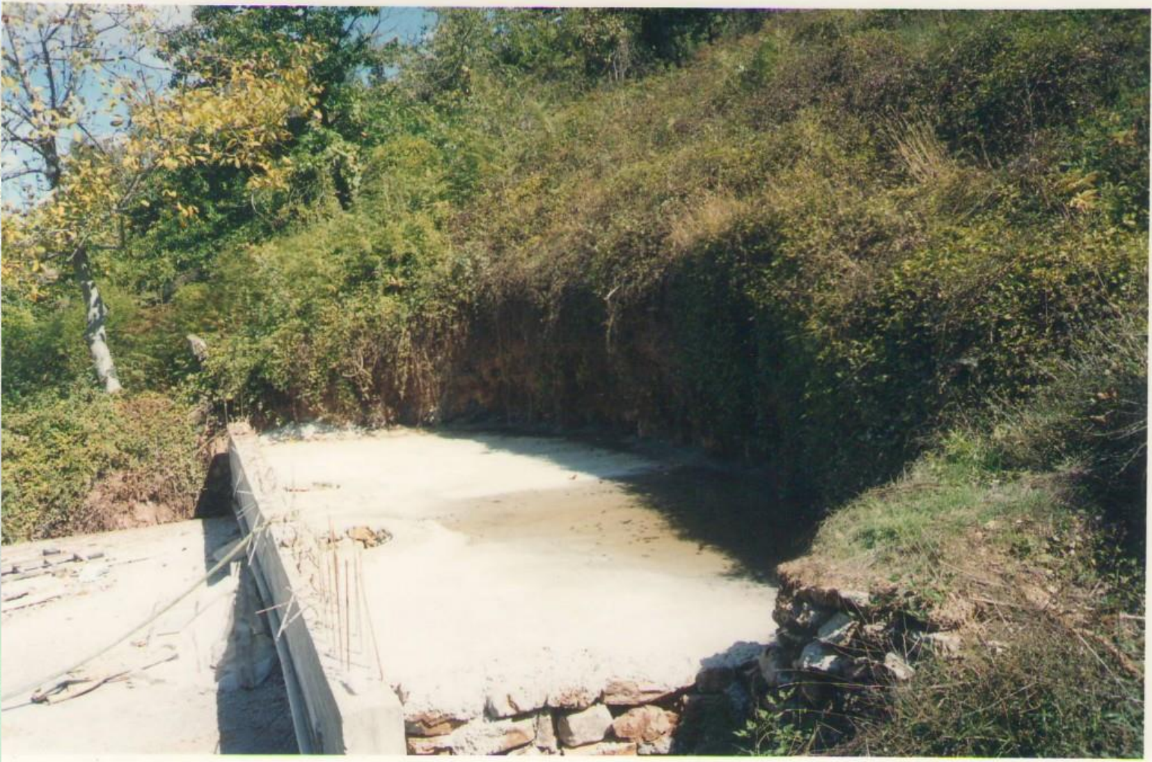
Υδρομάστευση στην περιοχή των Καλαβρύτων (από https://teucris.net )
