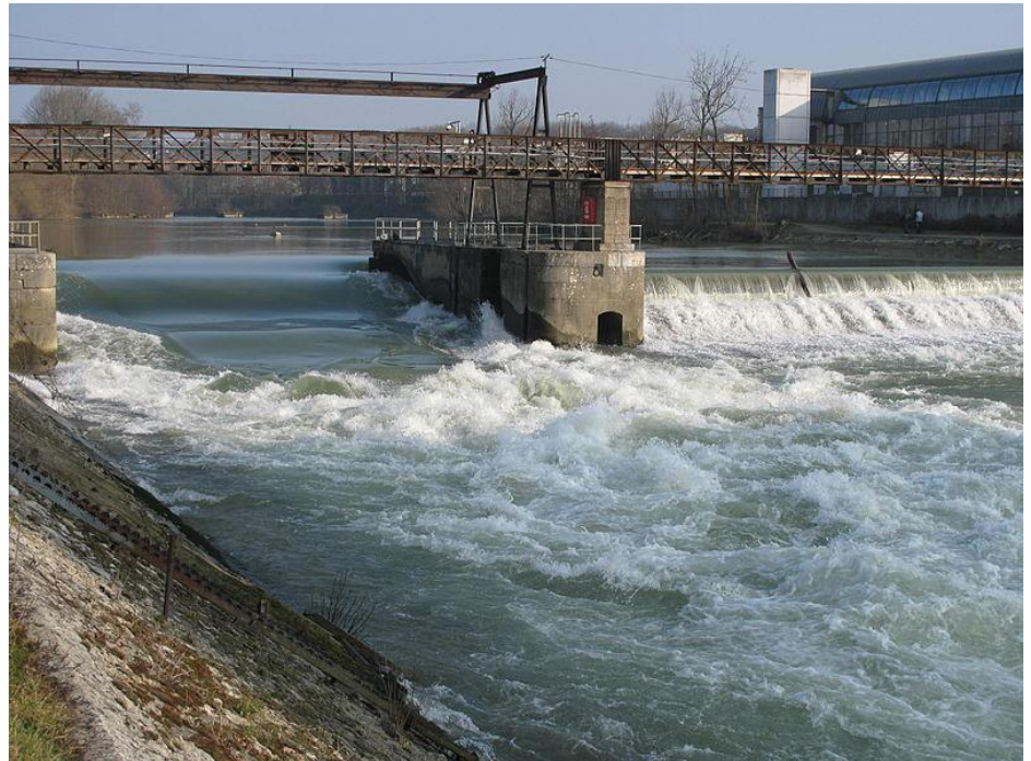
Εικ.4: Παράδειγμα γραμμικής (αριστερά) και τυρβώδους ροής (δεξιά) σε φράγμα.
