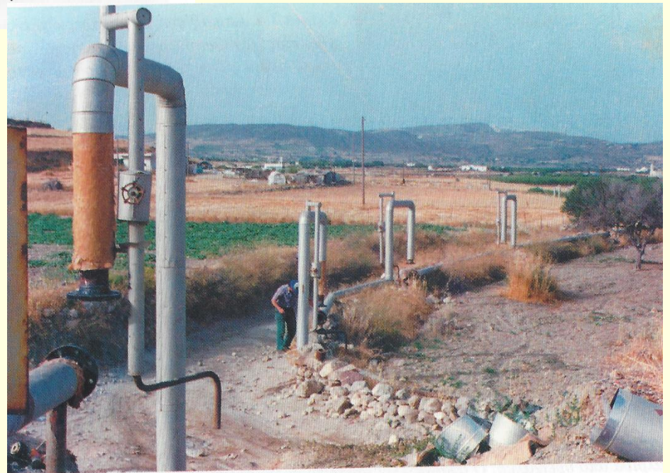
Σχήμα 6.48. Φωτογραφία του αγωγού επανεισαγωγής στη Μήλο.
