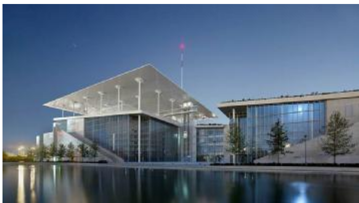
Κέντρο Πολιτισμού Ίδρυμα Σταύρος Νιάρχος – τσιμέντο για την κατασκευή της οροφής με ειδική τεχνική (ferrocement)
