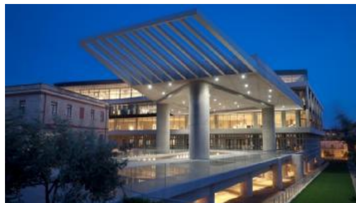
Μουσείο Ακρόπολης – τσιμέντο για την παραγωγή εμφανούς σκυροδέματος σταθερού χρώματος
