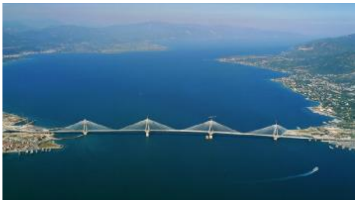
Γέφυρα Ρίου-Αντιρρίου – ειδικοί τύποι τσιμέντου για το σύνολο της κατασκευής εντός και εκτός θαλάσσης
