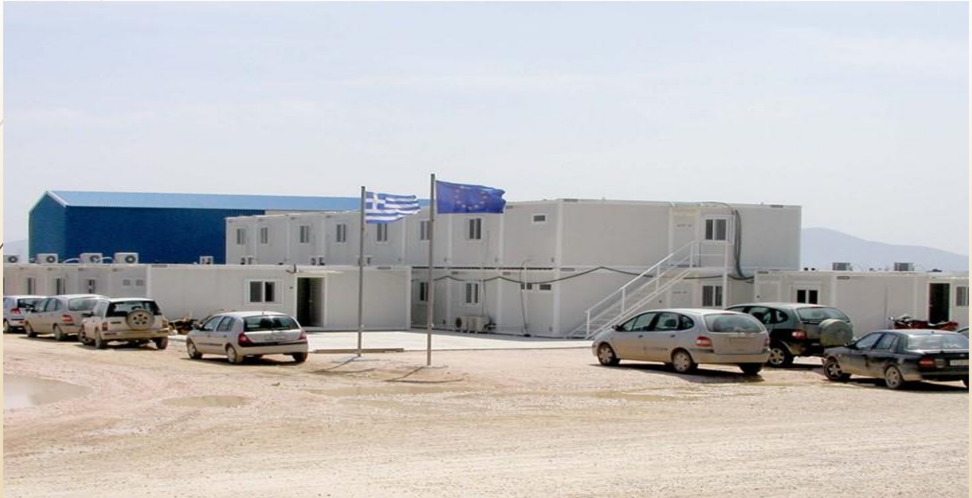
Συγκρότημα εργοταξιακών γραφείων από προκατασκευασμένους οικίσκους τύπου ISOBOX
