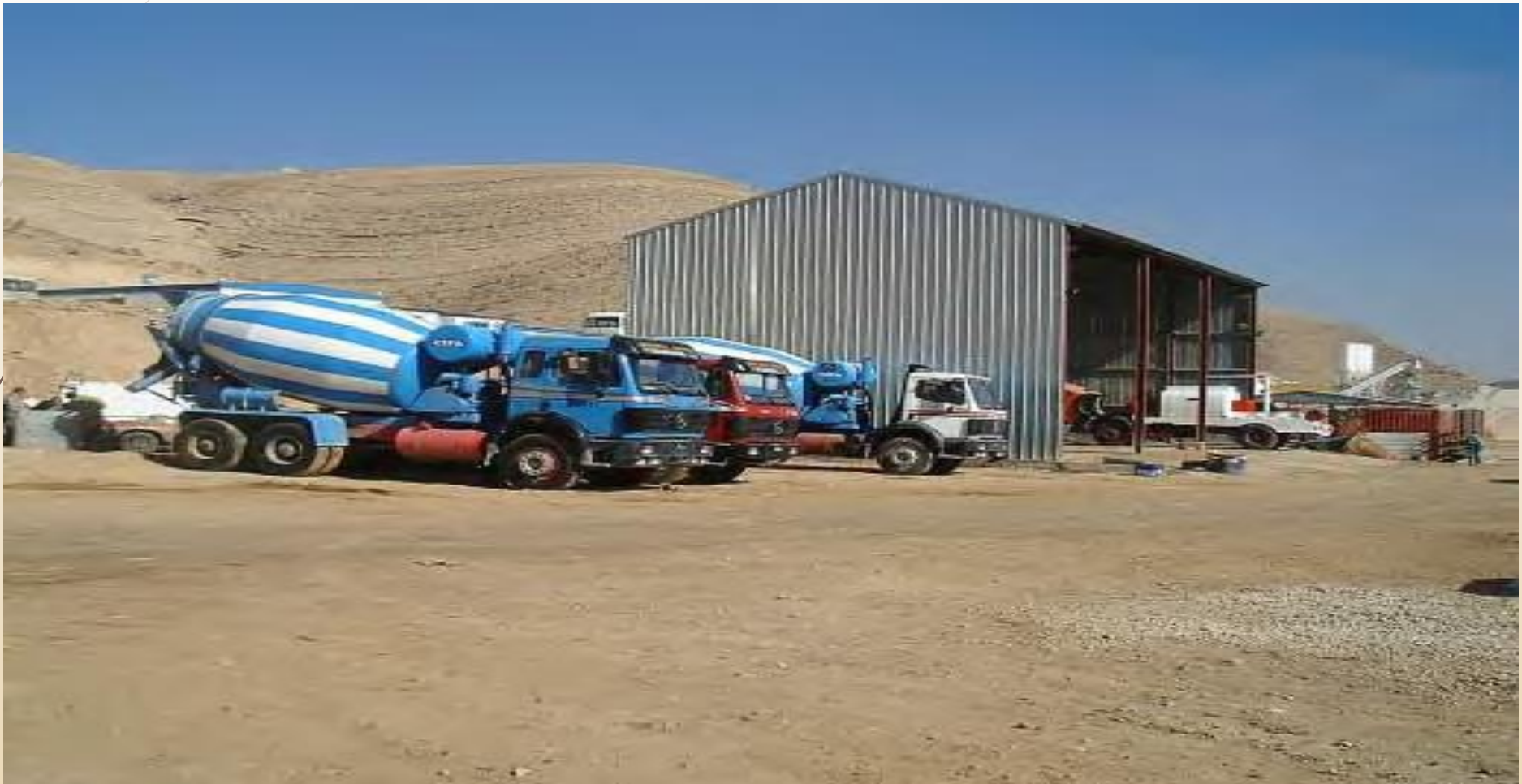
Τυπικό εργοταξιακό συνεργείο
