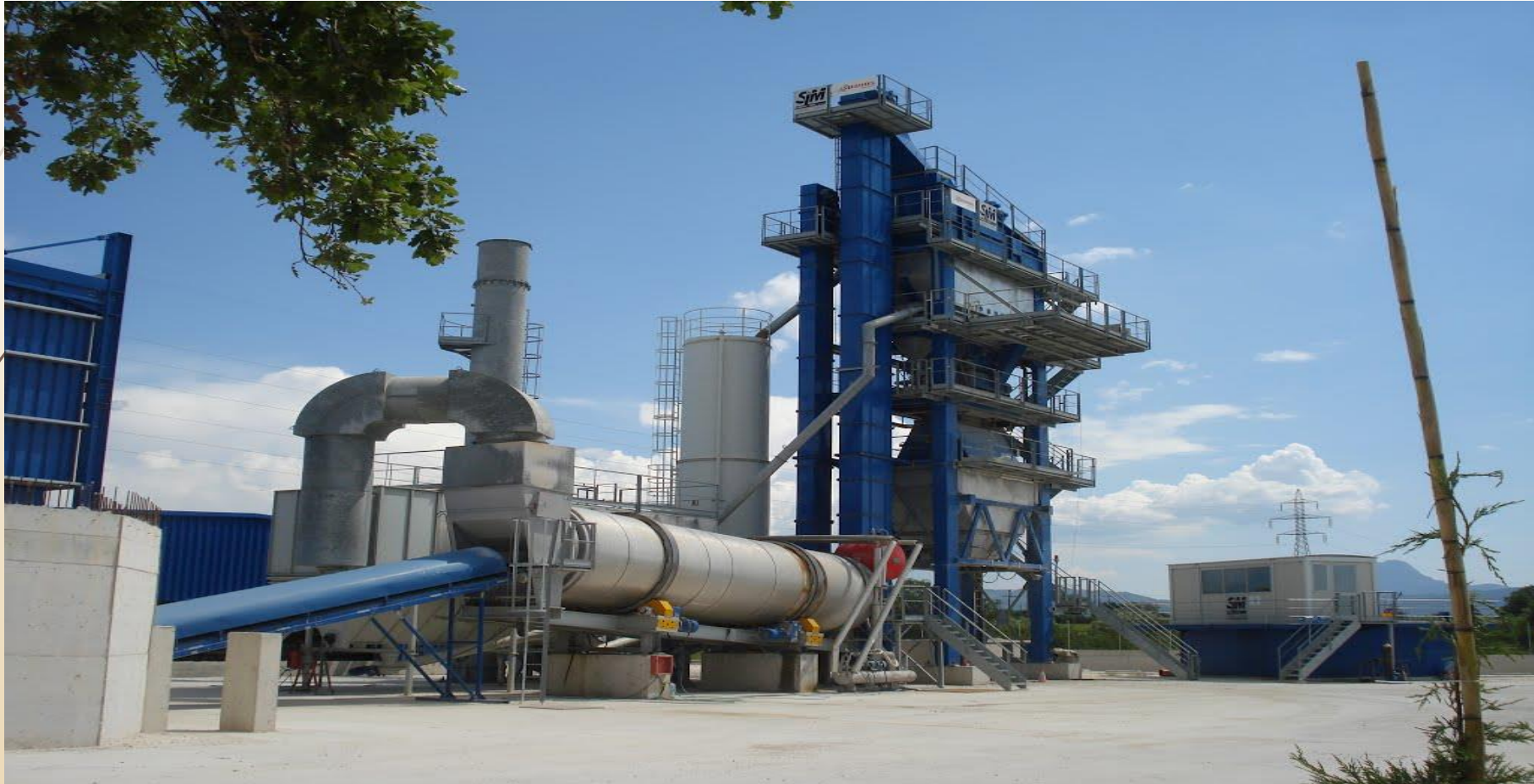
Συγκρότημα παραγωγής ασφαλτικού σκυροδέματος (Άξονας MB ΑΤΕΒΕ)
