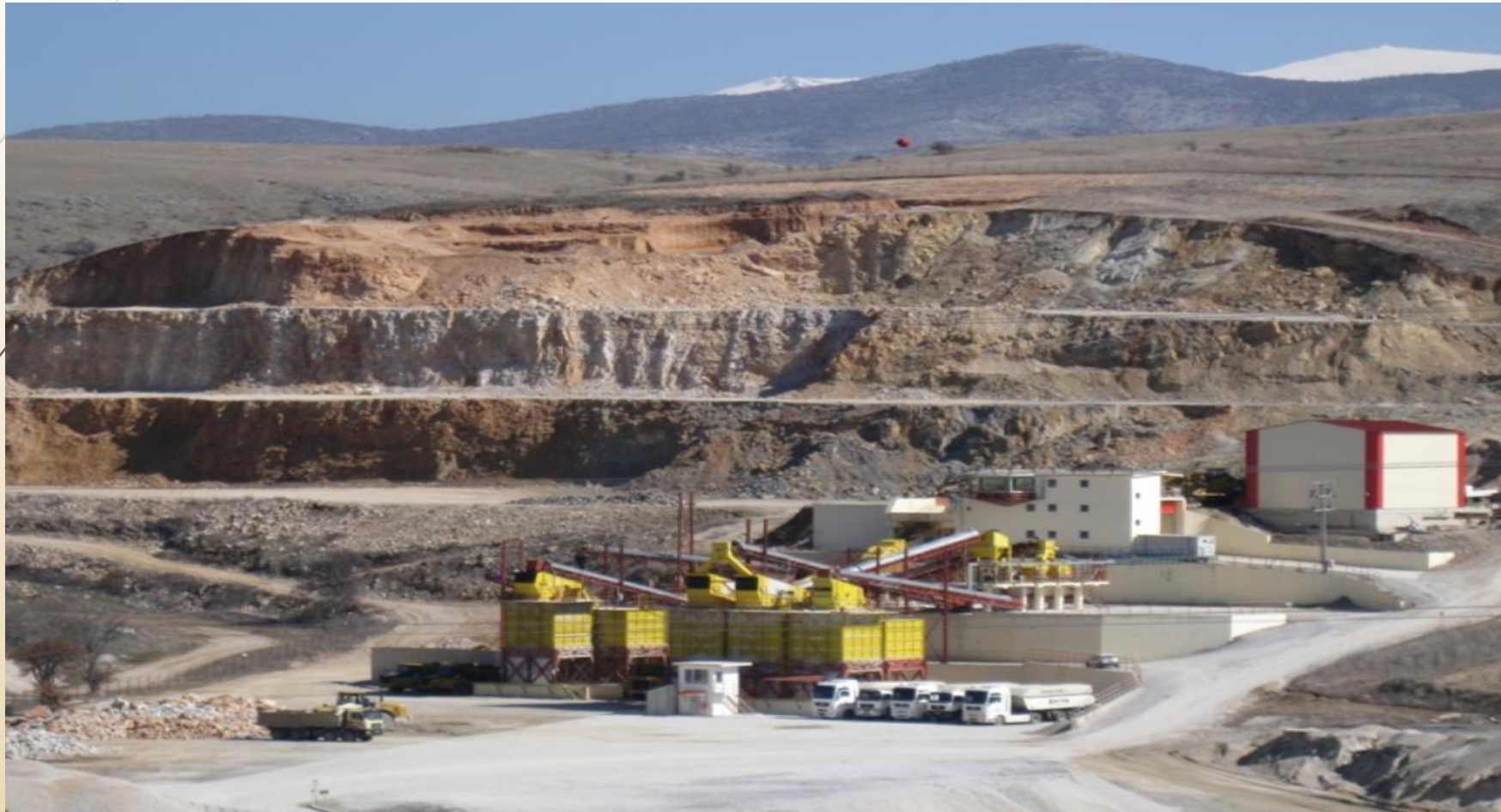
Λατομείο & σταθερή διάταξη παραγωγής αδρανών
