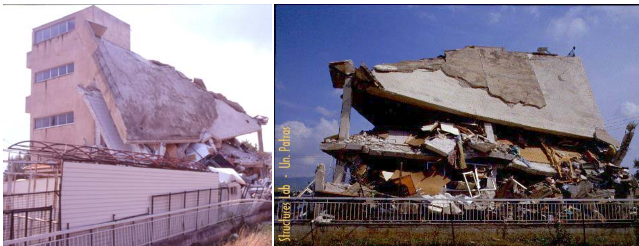
Σχήμα 3.1 Κατάρρευση κτιρίου κατά τη στρεπτική απόκριση περί το δύσκαμπτο πυρήνα κλιμακοστασίου, κ.λ.π. στη γωνία (Σεισμός Πάρνηθας, 1999).
