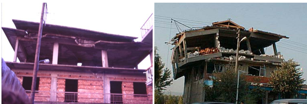
Σχήμα 3.4 Καταρρεύσεις ανώτερων ορόφων γιά καθ' ύψος μεταβολή των διαστάσεων κάτοψης (Αριστερά: Καλαμάτα, 1986. Δεξιά: σεισμός Κοτζέλι, Τουρκία, 1999).
