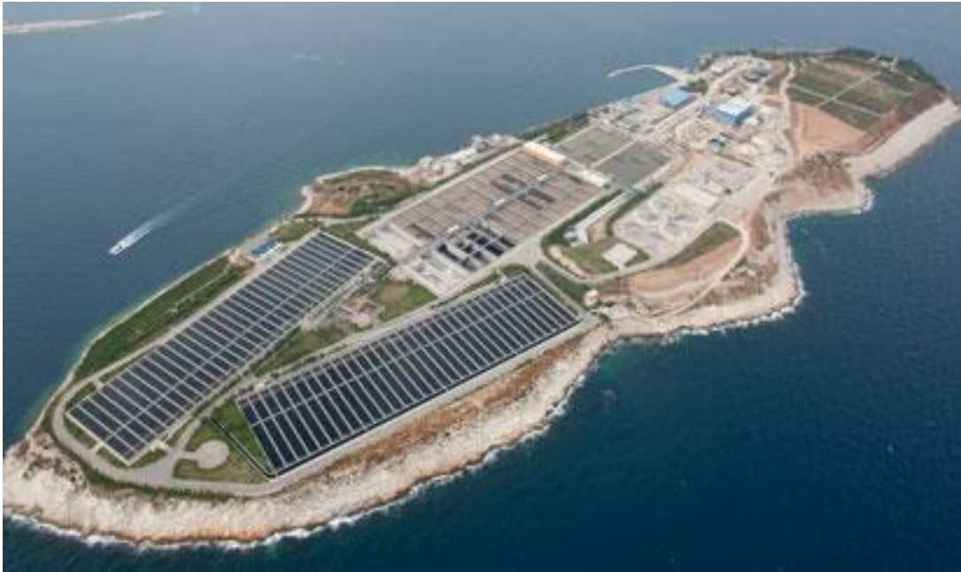
Εγκατάσταση Επεξεργασίας Λυμάτων στην Ψυττάλεια (πηγή: http://www.ypeka.gr ).
