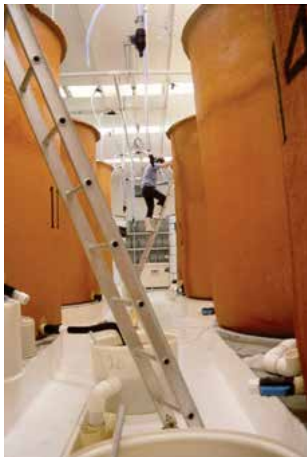
Εικόνα 3.8 Μεγάλου μεγέθους (20.000 L) δεξαμενές καλλιέργειας εκκολαπτηρίου από υαλόνημα σε ένα εκκολαπτήριο στρειδιών στην Τασμανία της Αυστραλίας. Παρατηρήστε ότι η πρόσβαση στην κορυφή των δεξαμενών απαιτεί τη χρήση σκάλας, και την άνω (κορυφή) πλευρά της δεξαμενής γίνεται παροχή νερού, αέρα και μικροφυκών. Πηγή: Αναπαράγεται με την άδεια από τον Paul Southgate.
