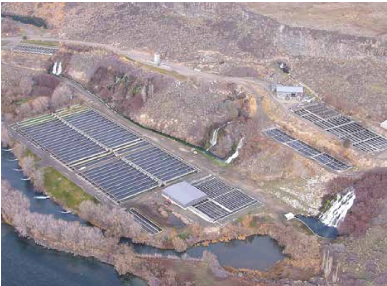
Εικόνα 4.14 Μια μεγάλη εγκατάσταση υδατοκαλλιέργειας συνεχούς ροής που χρησιμοποιείται για την καλλιέργεια ιριδίζουσας πέστροφας ( Oncorhynchus mykiss ) στο φαράγγι του ποταμού Snake, Idaho, ΗΠΑ. Η εγκατάσταση τροφοδοτείται με αρτεσιανά νερά με σταθερή ετήσια θερμοκρασία 15 °C που ρέει ελεύθερα από διάφορες πηγές στα τοιχώματα του φαραγγιού. Το νερό διοχετεύεται στις καναλόμορφες δεξαμενές και απορρίπτεται στον ποταμό Snake. Πηγή: Αναπαραγωγή με άδεια από το Ερευνητικό Ινστιτούτο Νερού του Πανεπιστημίου του Αίνταχο, 2017.
