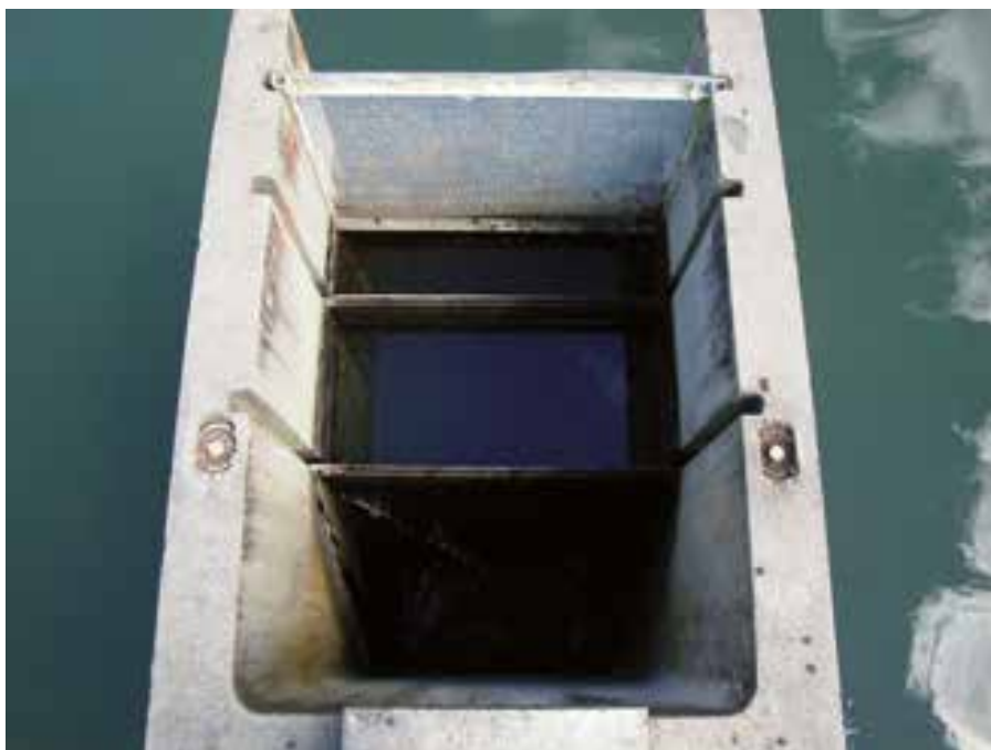
Εικόνα 3.3. Ένας υδατοφράκτης ή “καλόγερος” που ελέγχει το νερό εκροής από μια λιμνοδεξαμενή καλλιέργειας γαρίδας. Οι αυλακώσεις στους τοίχους του σκυροδέματος κρατούν ένα διαχωριστικό (κορυφή) για να ρυθμίζουν τις κινήσεις των ζώων και οι σανίδες (μέσο και κάτω) ρυθμίζουν την στάθμη και τη ροή του νερού. Το νερό διέρχεται από το διαχωριστικό και πάνω από τις σανίδες και αποστραγγίζεται μακριά από τη λιμνοδεξαμενή σε ένα κανάλι. Πηγή: Αναπαράγεται με άδεια από τον Igor Pirozzi.
