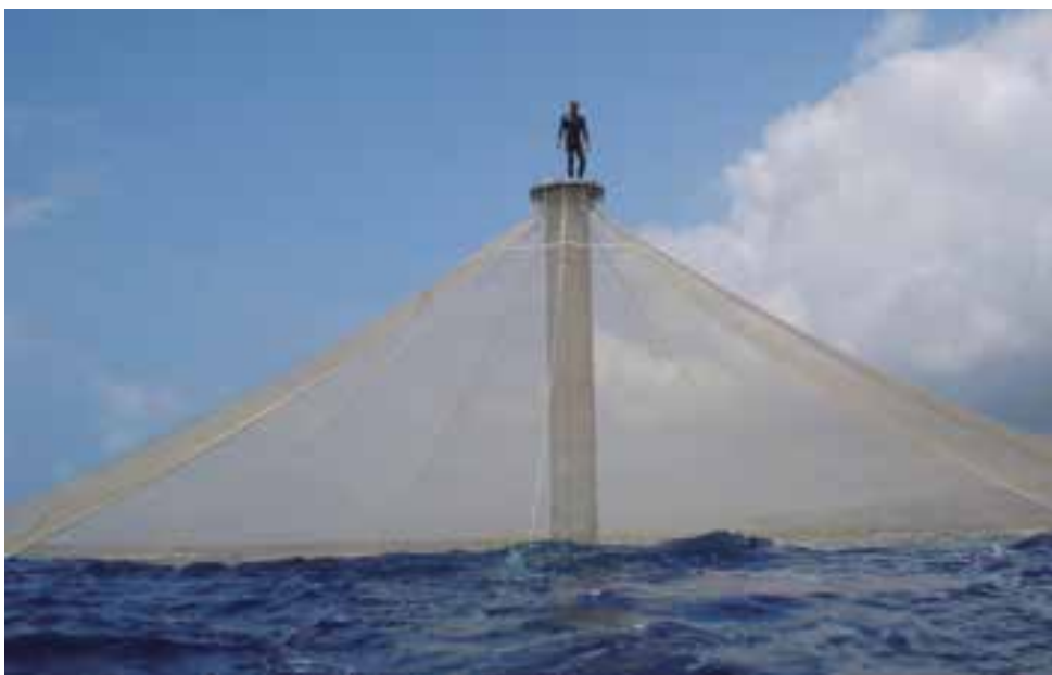
Εικόνα 1.8 Ο θαλάσσιος κλωβός Sea Station 3000 ήταν ένας πλήρως βυθιζόμενος θαλάσσιος κλωβός 3000 m 3 (24 m διάμετρο x 16,5 m ύψος). Κατά τη λειτουργία του, ο θαλάσσιος κλωβός βυθίζονταν σε βάθος 10 m, περίπου 800 μ. από την ακτή Κονα του Μεγάλου Νησιού της Χαβάης. Εκτρέφονταν σε αυτόν έως και 70.000 άτομα μαγιάτικο Seriola rivoliana (Kona Kampachi®). Ο Διευθυντής της εταιρίας βρίσκεται στην κορυφή της δοκού της ημιβυθισμένης κατασκευής. Πηγή: Αναπαράγεται με άδεια από την Kona Blue Water Farms, Inc., 2017.
