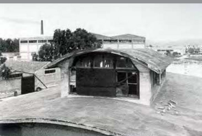
Καμπυλωμένες πλάκες οπλισμένου σκυροδέματος στις αποθήκες του "Κρόνος"
