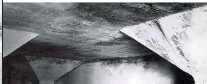
Πρωτοποριακά μυκητοειδή υποστυλώματα στις δεξαμενές του "Κρόνος"
