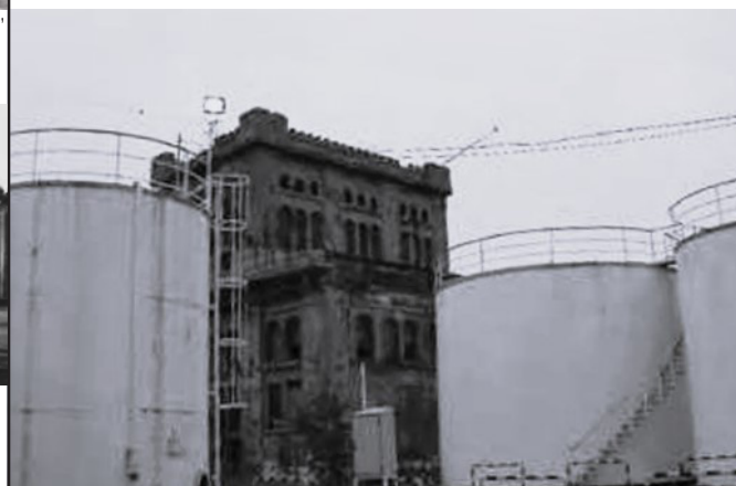
Οι δεξαμενές του "Κρόνος" με φόντο τον πύργο του αποστακτηρίου.
