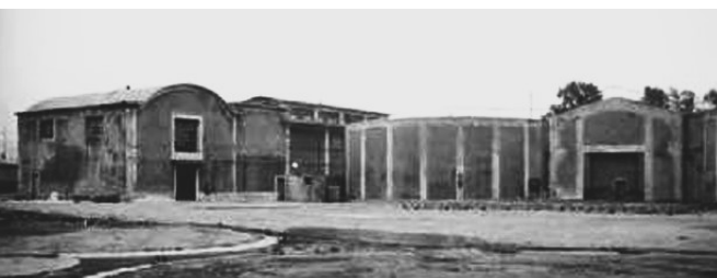
Τα θολωτά κτίρια των αποθηκών οινοπνεύματος και οι δεξαμενές αραίωσης μελάσσας.
