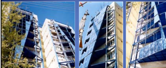
Κατασκευή – Τύπος Β
