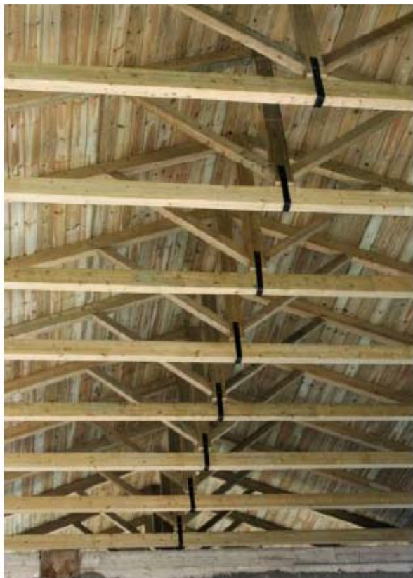
Εικόνα 3.6 Τριγωνικά ζευκτά στέγης από εμποτισμένες διατομές φυσικής ξυλείας κωνοφόρων. Τα ζευκτά γεφυρώνουν άνοιγμα περίπου 9,0 m.
