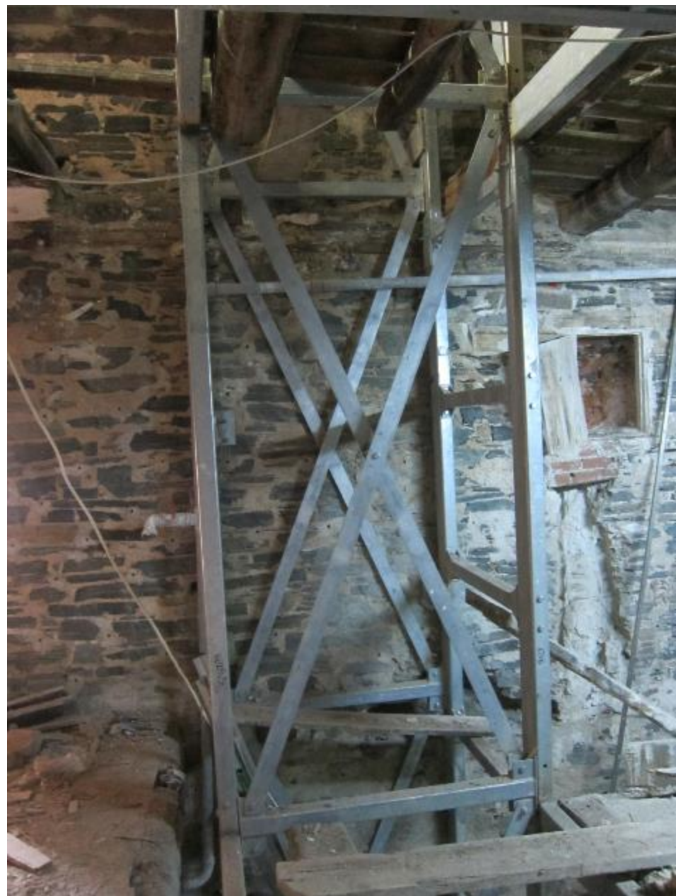
Απόψεις από τον φορέα του φρέατος του ανελκυστήρα.
