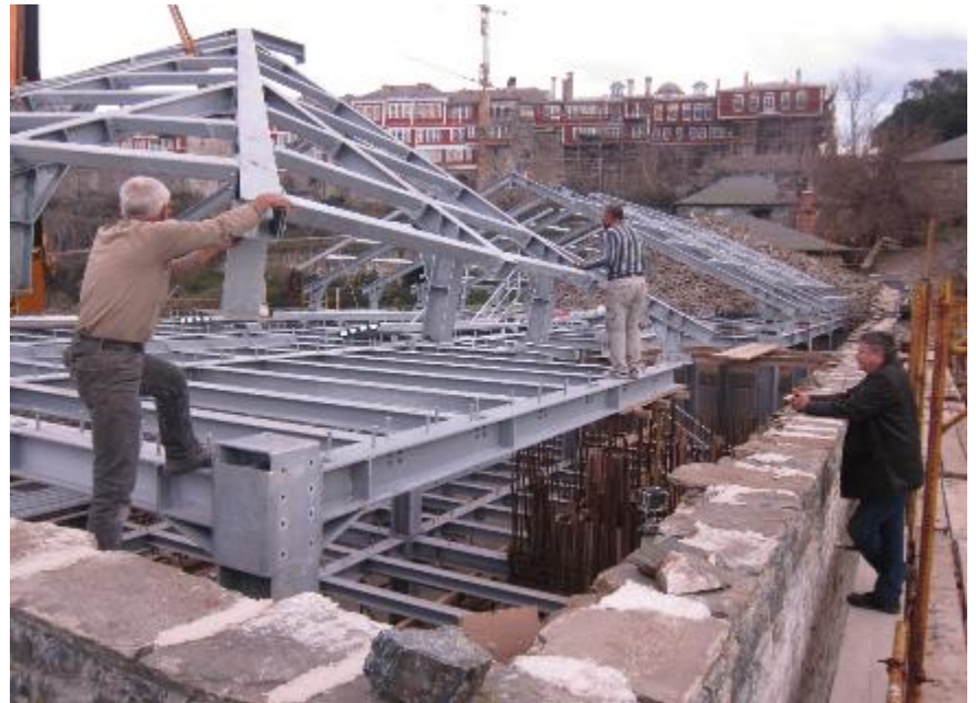
Απόψεις από τη συναρμολόγηση του μεταλλικού φορέα που είναι εν θερμώ γαλβανισμένος
