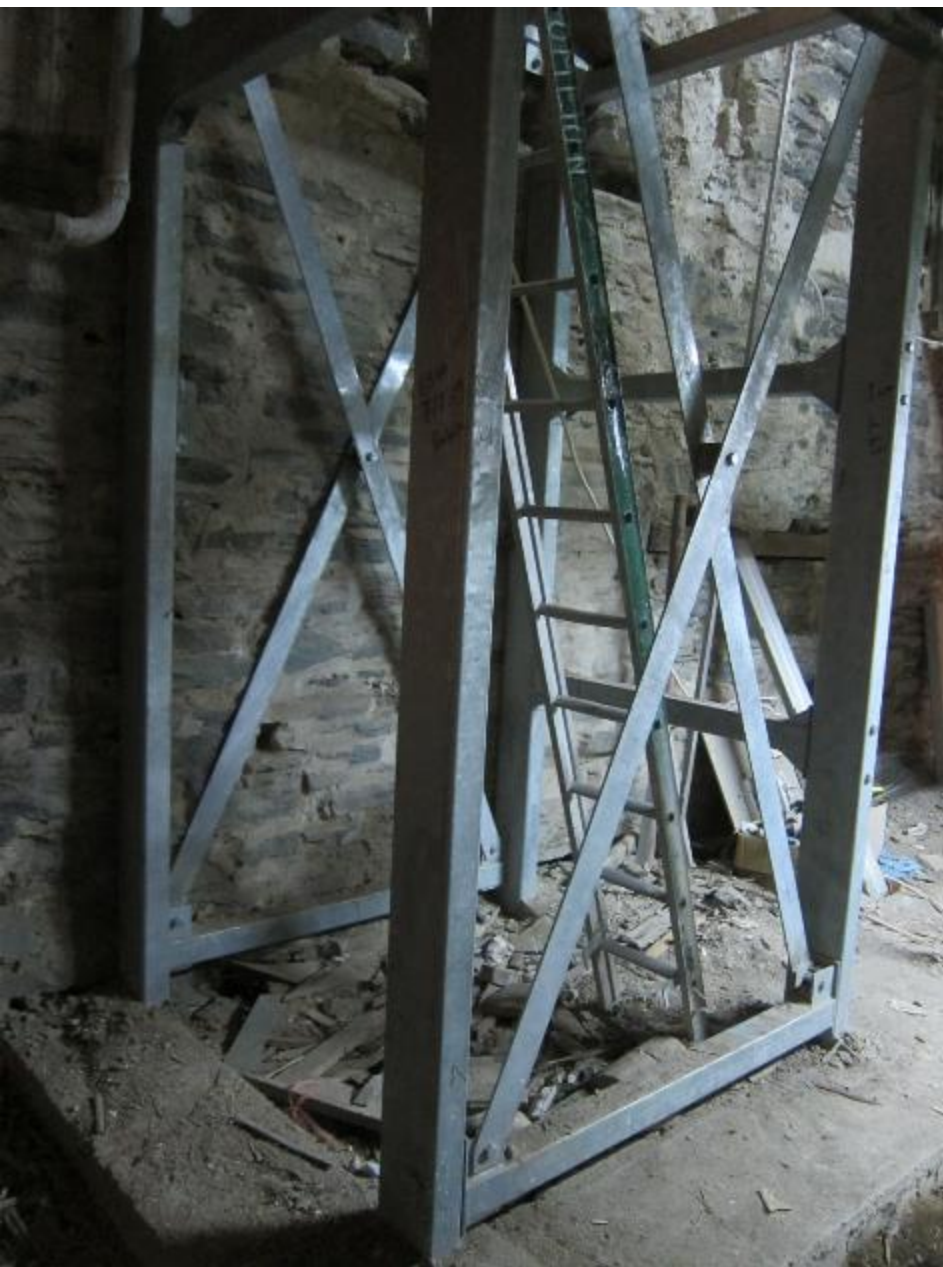
Απόψεις από τον φορέα του φρέατος του ανελκυστήρα.
