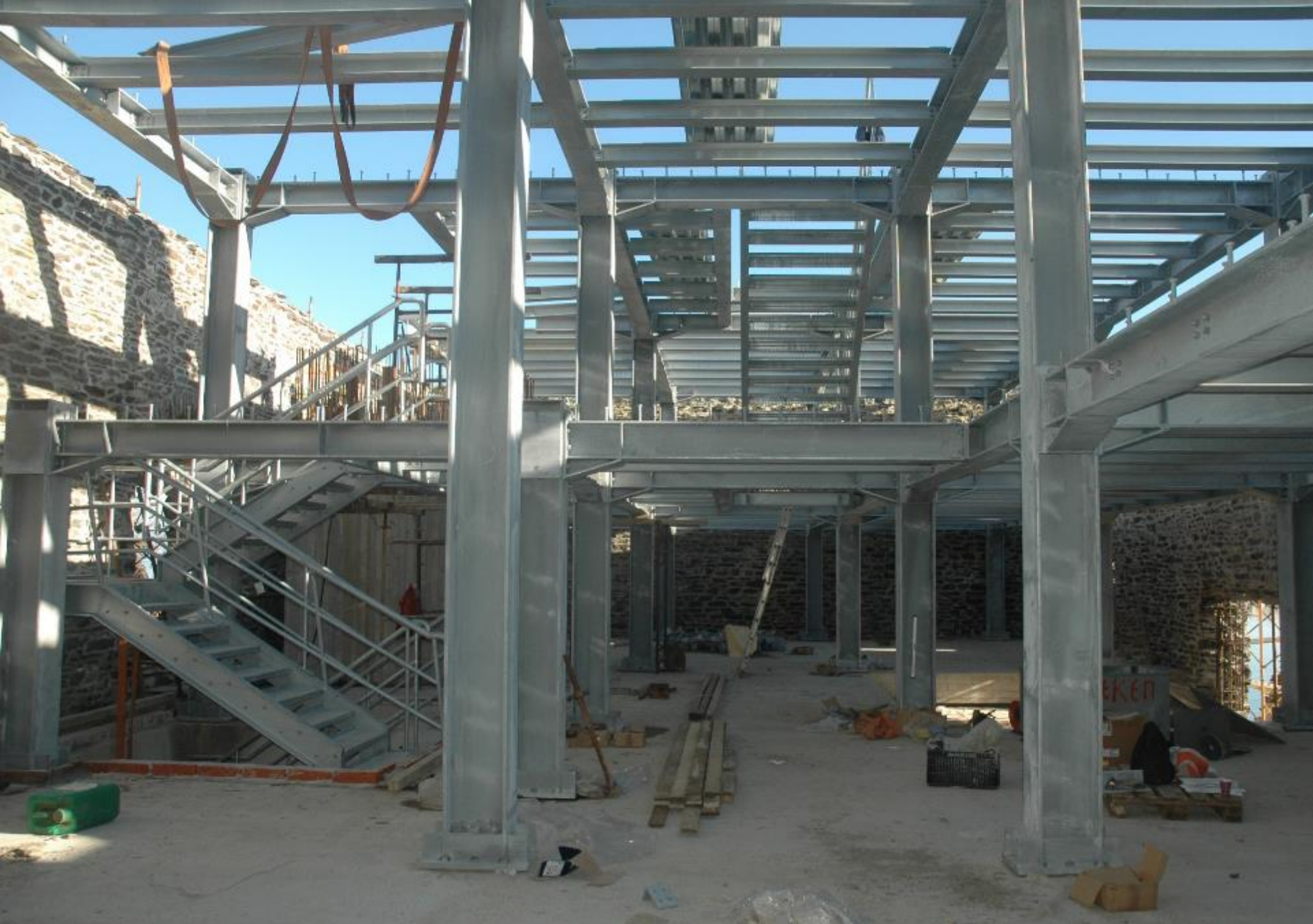
Ο μεταλλικός φορέας κατά τη διάρκεια της συναρμολόγησής του.
