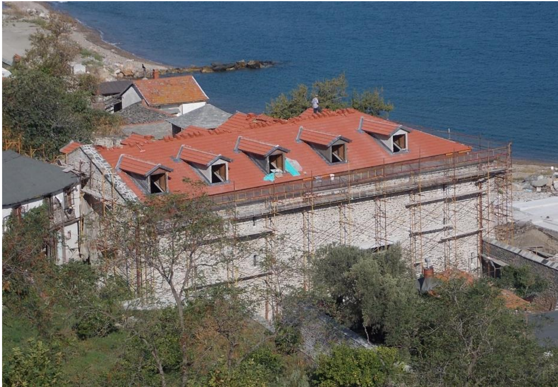
Το κτήριο της παλαιάς χορταποθήκης λίγο πριν την ολοκλήρωση των εργασιών της επικάλυψης της στέγης.
