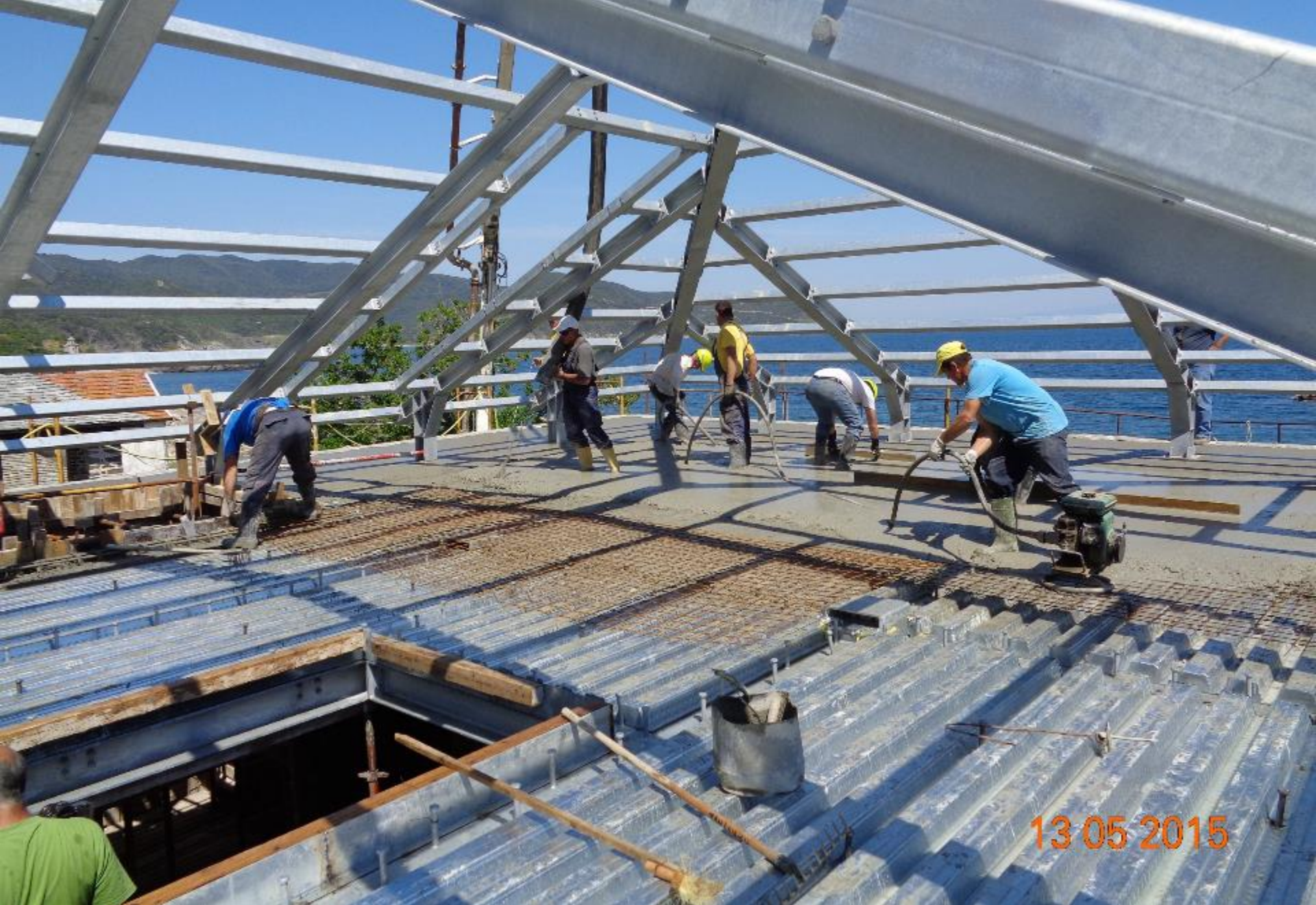
Σκυροδέτηση του σύμμικτου πατώματος στη στάθμη της σοφίτας.
