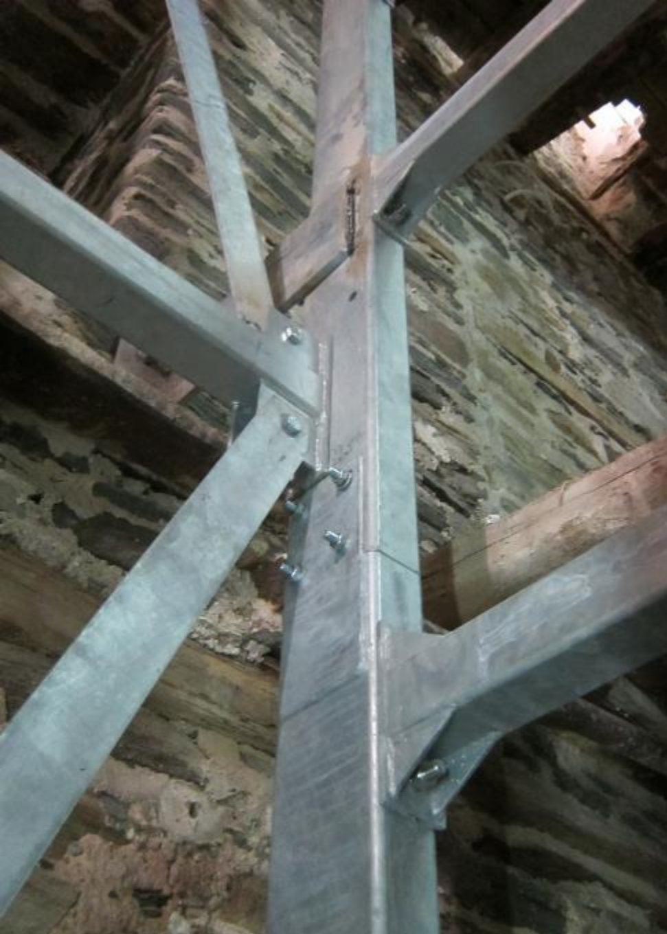
Λεπτομέρειες από τους κόμβους του φορέα του φρέατος του ανελκυστήρα.
