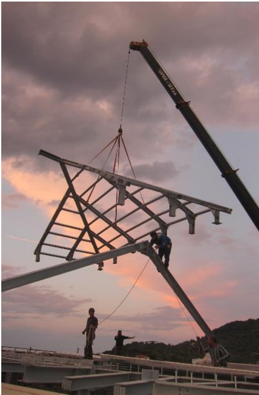
Απόψεις από τη συναρμολόγηση του μεταλλικού φορέα που είναι εν θερμώ γαλβανισμένος
