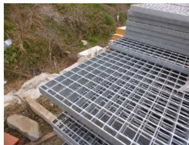
Στοιχεία του φορέα του μεταλλικού παταριού από γαλβανισμένες κοιλοδοκούς, πριν τη συναρμολόγησή τους.
