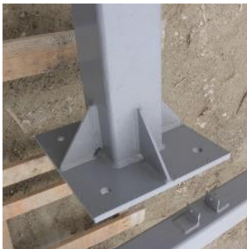
Στοιχεία του φορέα του μεταλλικού παταριού από γαλβανισμένες κοιλοδοκούς, πριν τη συναρμολόγησή τους.
