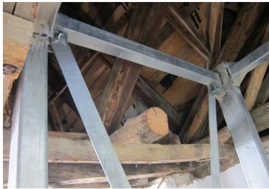
Λεπτομέρειες από τους κόμβους του φορέα του φρέατος του ανελκυστήρα.
