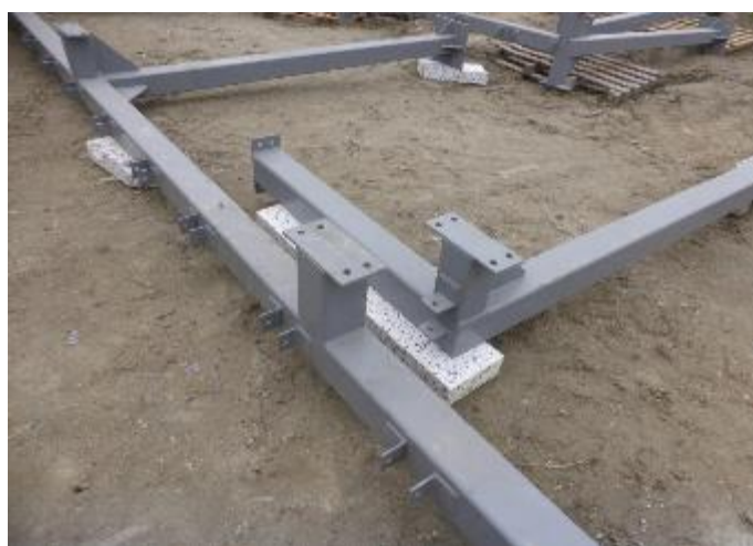
Στοιχεία του φορέα του μεταλλικού παταριού από γαλβανισμένες κοιλοδοκούς, πριν τη συναρμολόγησή τους.
